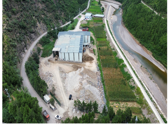
项目全貌现状（2）
