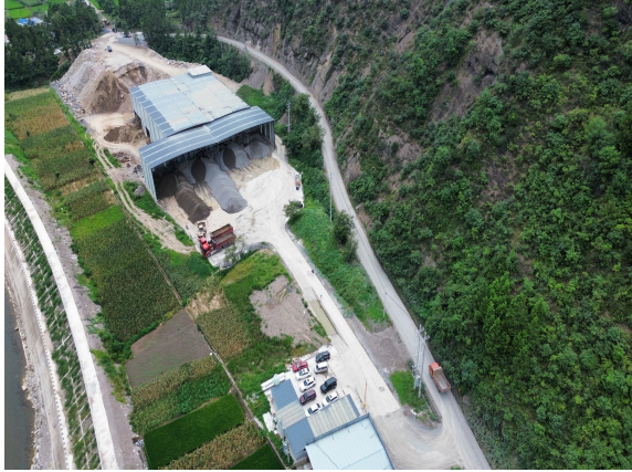
项目全貌现状（1）
