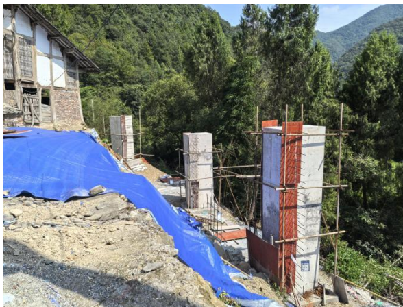
抗滑桩施工现状
