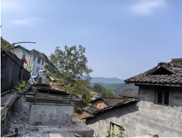
抗滑桩施工现状
