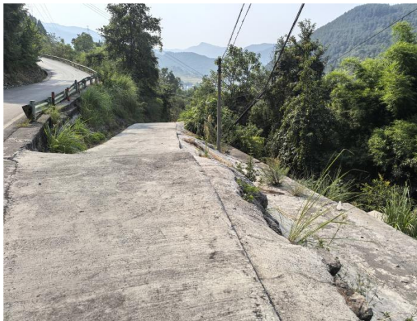
道路修复现状
