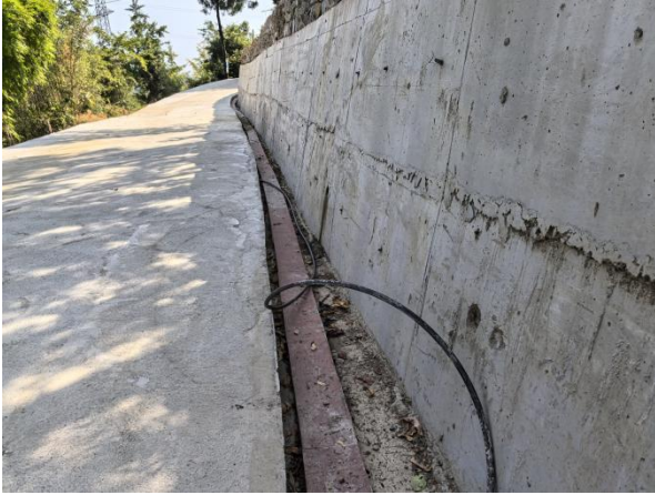
挡土墙、路面修复
