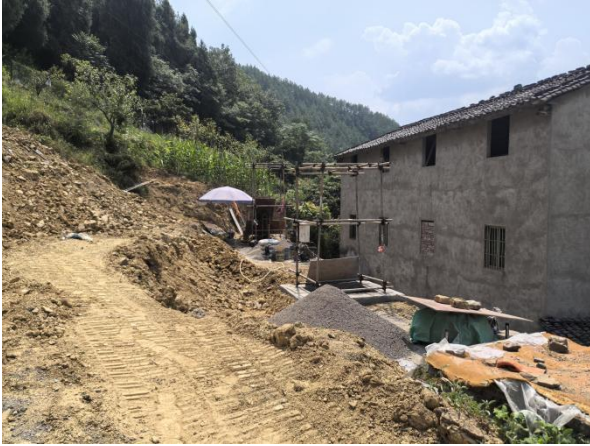
抗滑桩施工现状
