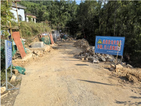
抗滑桩施工现状
