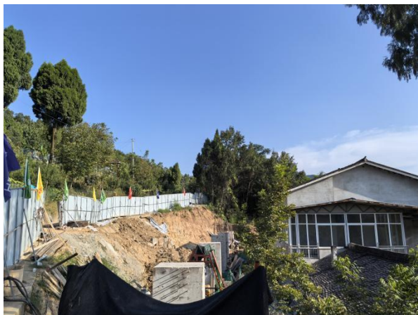
抗滑桩板墙施工现状
