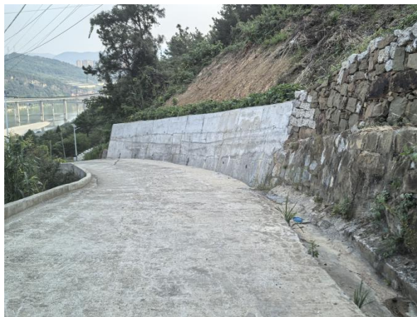
重力式挡土墙、排水沟
