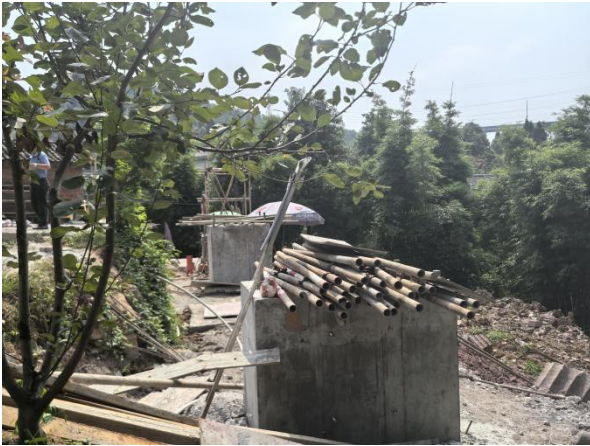
抗滑桩施工现状
