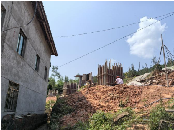
抗滑桩施工现状
