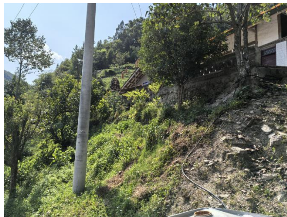
挡墙施工处现状
