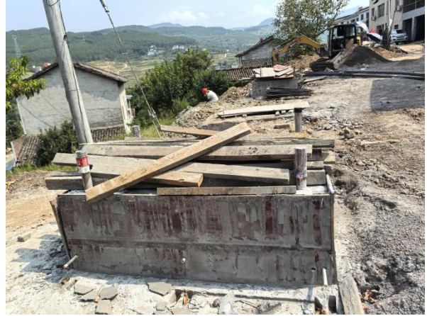
抗滑桩、院坝施工现状
