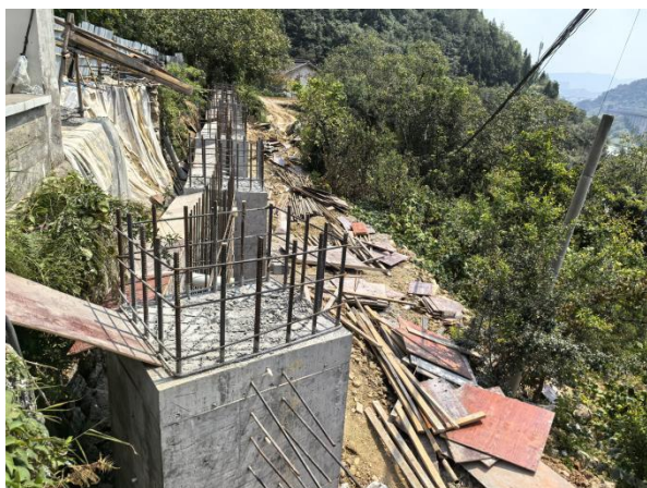
抗滑桩、挡土板施工现状
