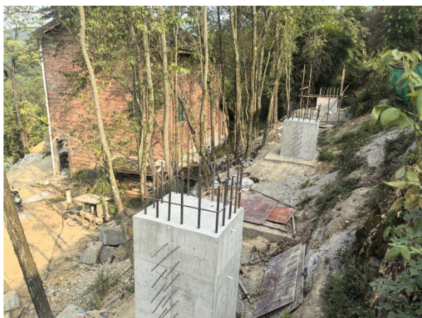
抗滑桩施工现状
