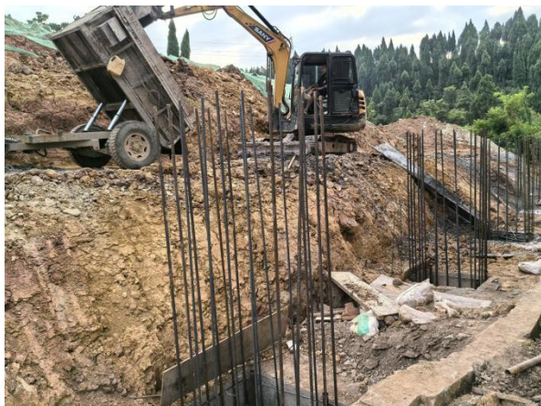
抗滑桩施工现状
