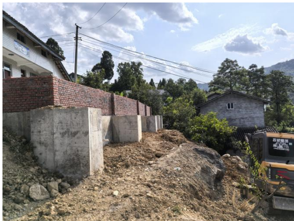
桩板墙施工现状
