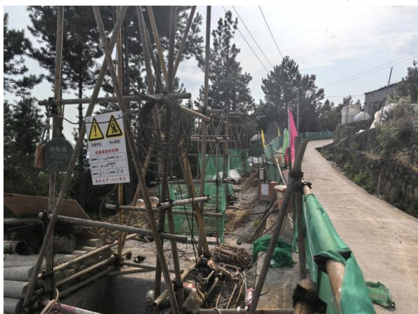
抗滑桩施工现状
