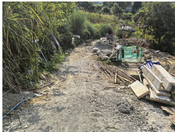
抗滑桩施工现状
