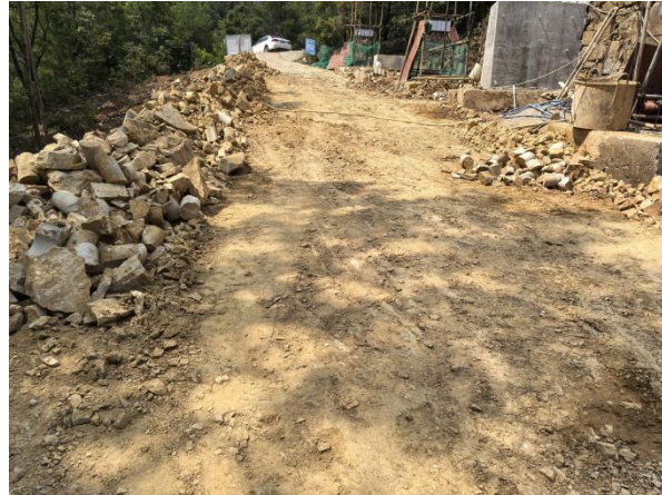
扩宽道路段施工现状
