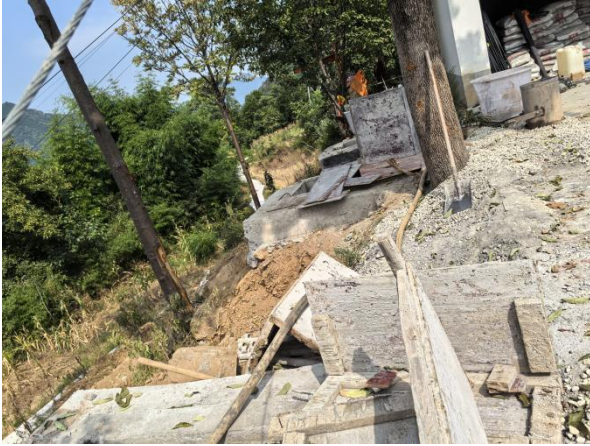
抗滑桩施工现状
