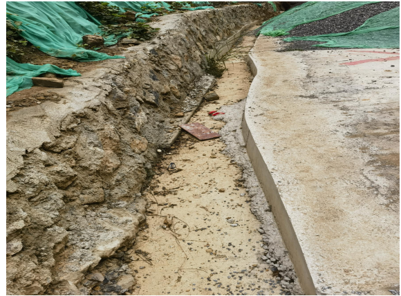
场地北侧排水沟
