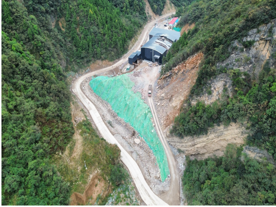
项目全貌现状（1）
