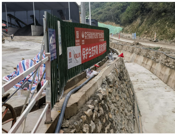
场地南侧排水沟
