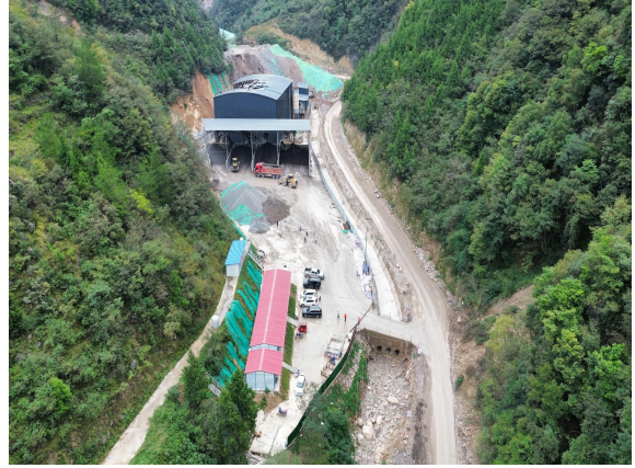
项目全貌现状（2）
