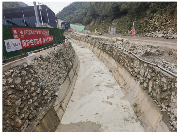
南侧水沟现状
