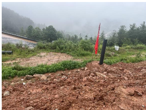
临时堆土区现状（拍摄于 2024.8）
