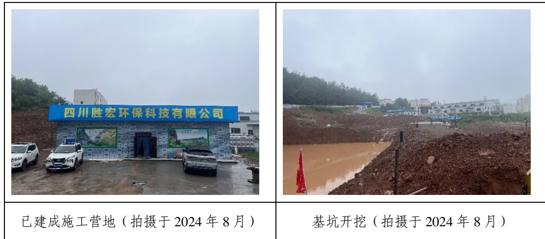
图 1.1.3-1 主体工程施工情况
