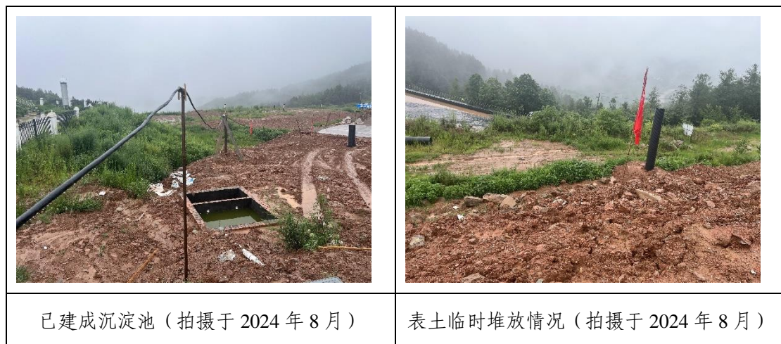
图 1.1.3-1 水土保持措施实施情况
