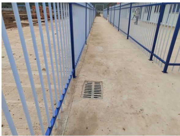
项目已建排水沟及雨水口
