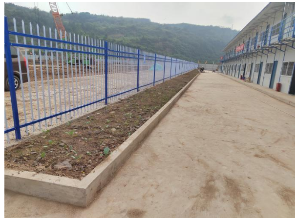
项目在建临时绿化带
