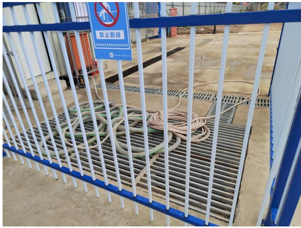
项目已建沉砂池
