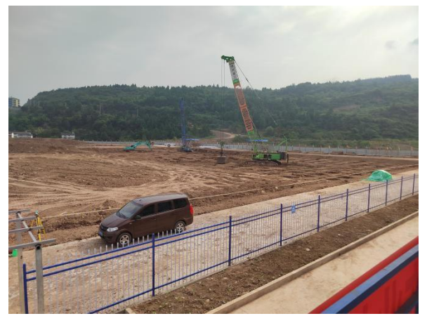
项目建设现状
