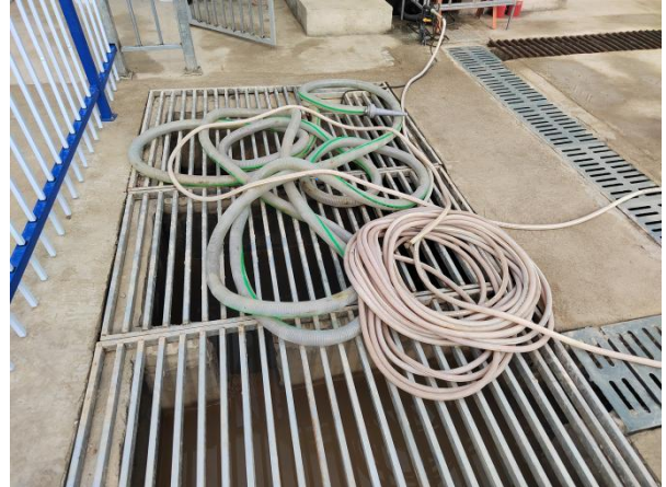
项目已建沉砂池
