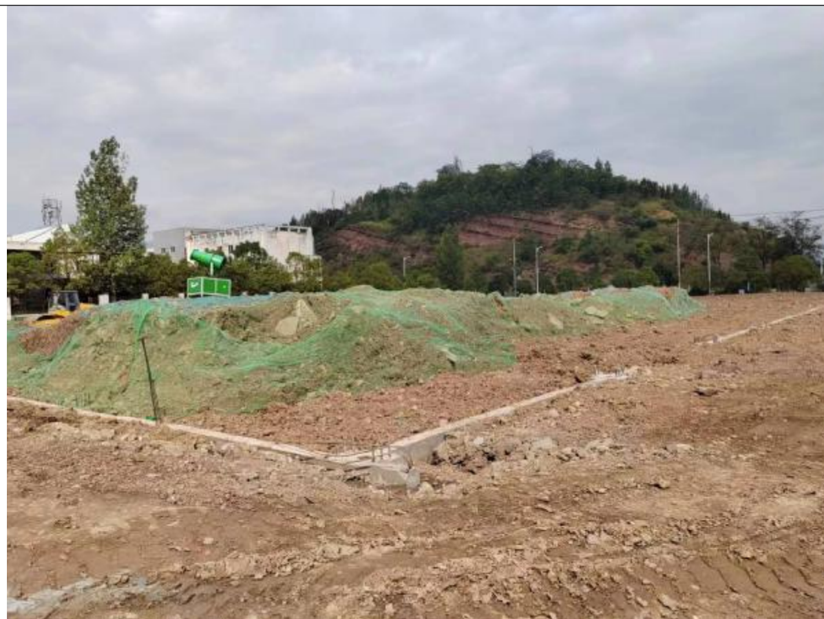
工程已实施的临时覆盖
