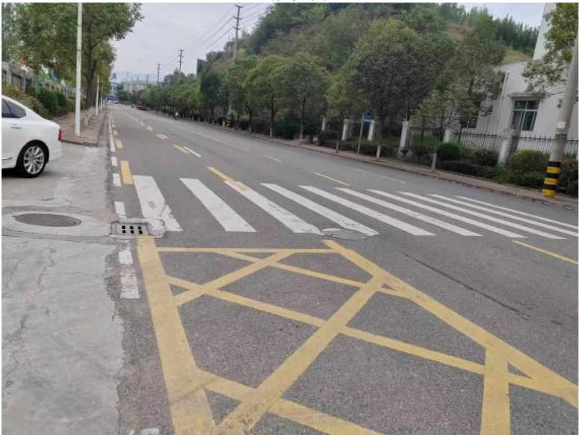
厂区场外道路 2
