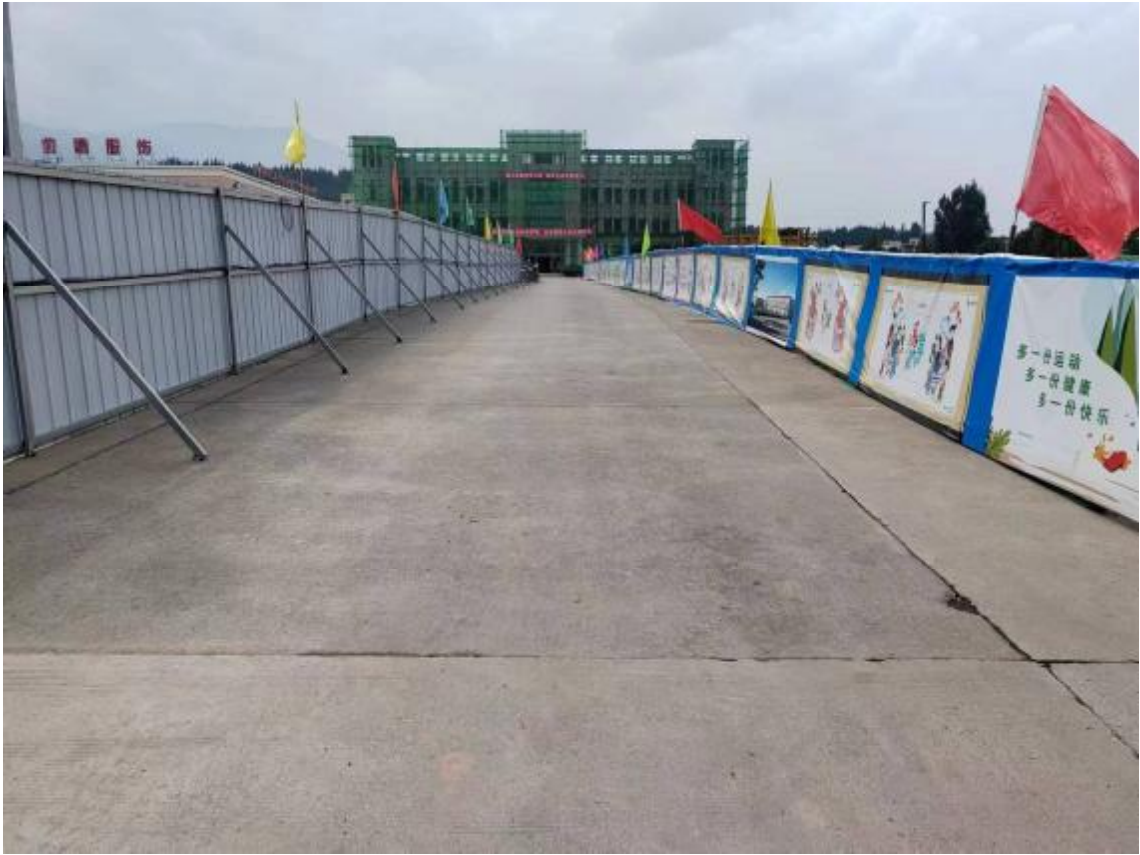
施工临时道路及临时围栏
