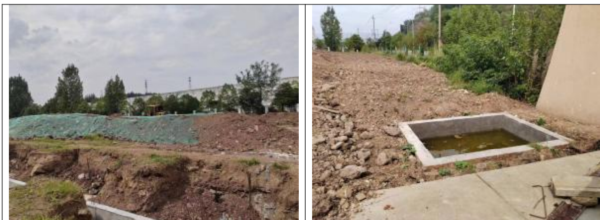
工程已实施的表土剥离、临时沉砂池
