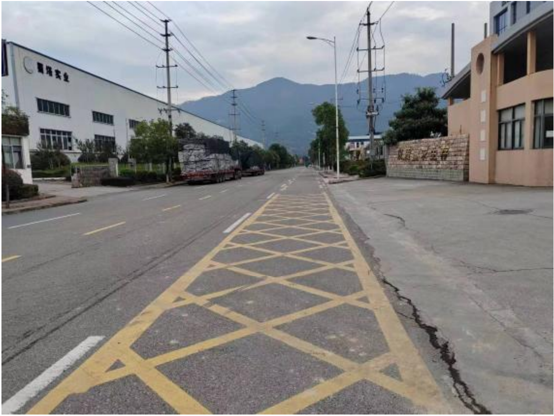
厂区场外道路 1
