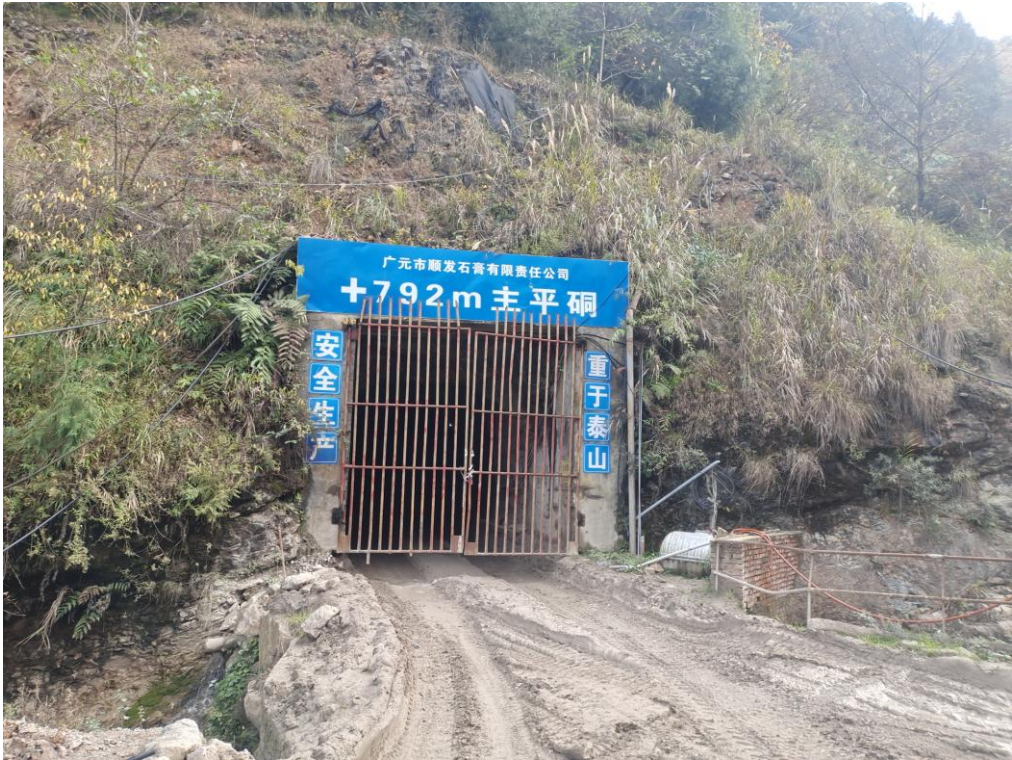
+792 主平硐出口现状
