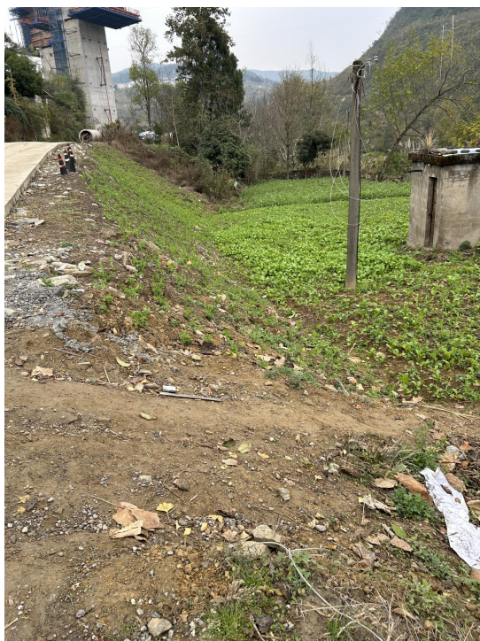
预制场工程区
