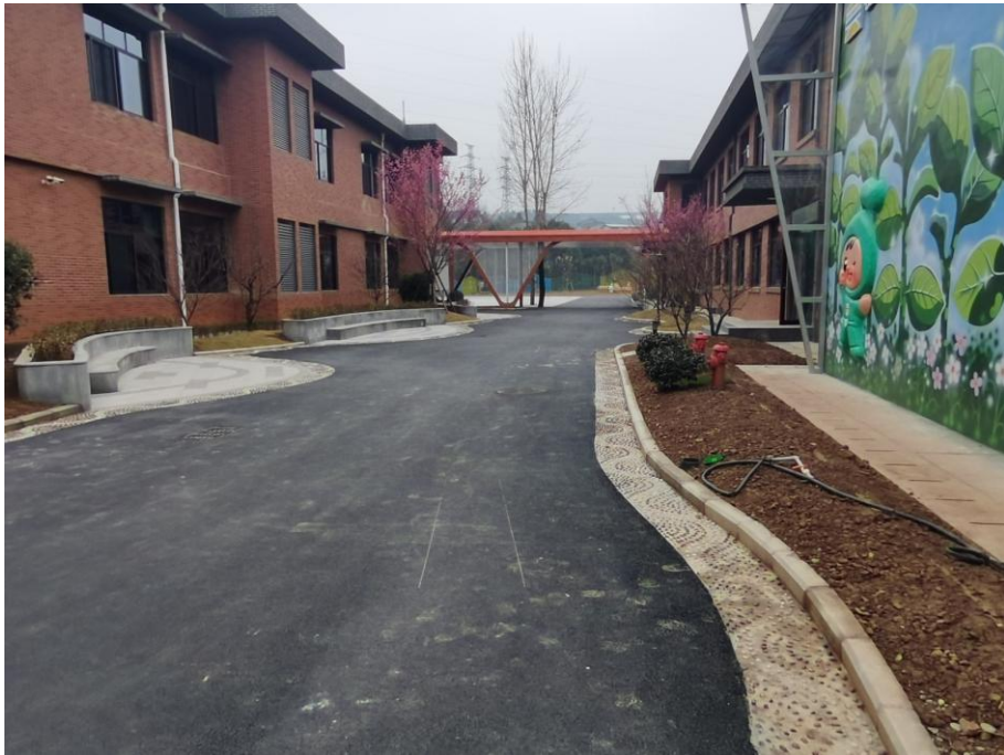
建筑物现状（左办公楼、右宿舍楼）
