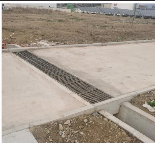
穿越道路排水沟现状
