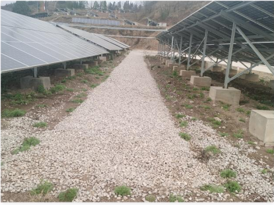
检修道路及光伏阵列现状(2#地块)
