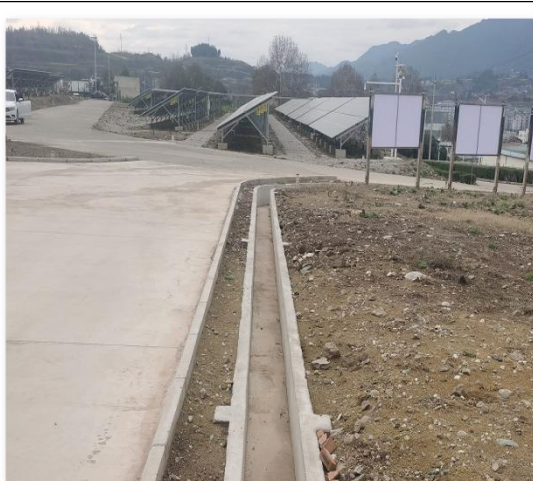
场内道路及旁侧排水沟（2、3#地块）
