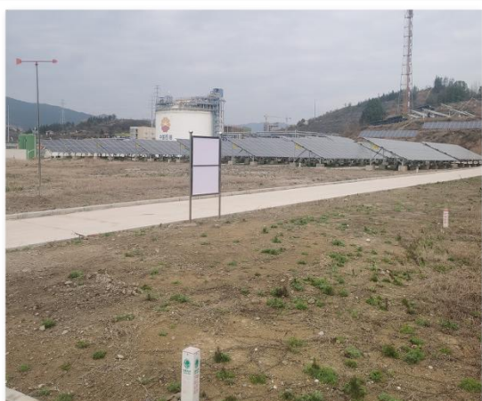
场内道路及阵列现状
