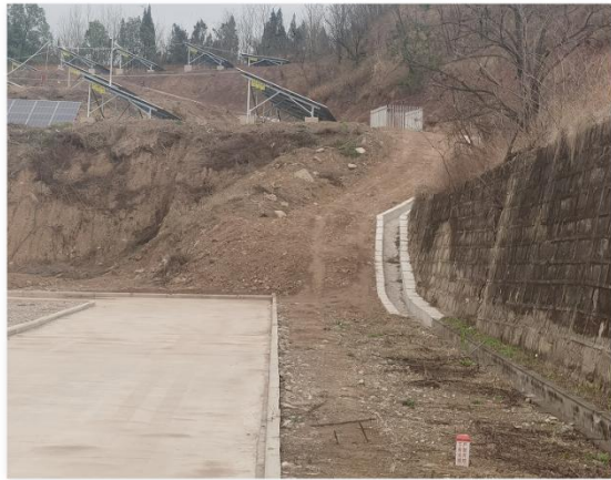
场内道路现状(存在裸露地表)
