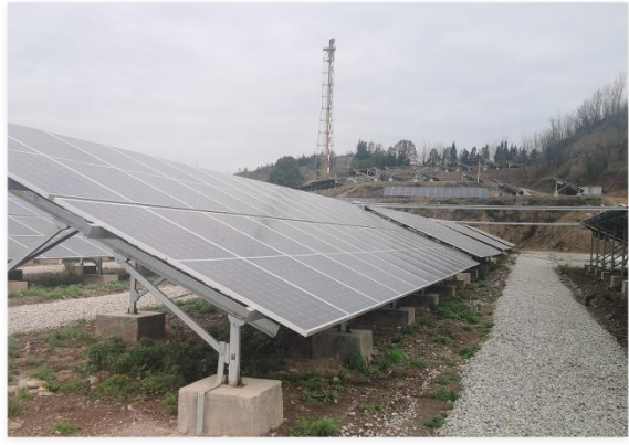
检修道路及光伏阵列现状
