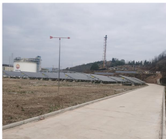
场内道路现状
