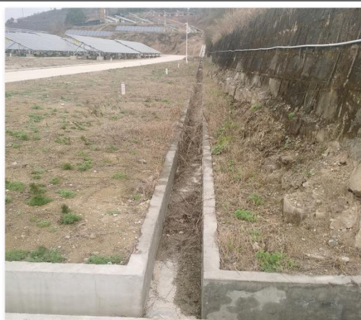
场内道路及旁侧排水沟
