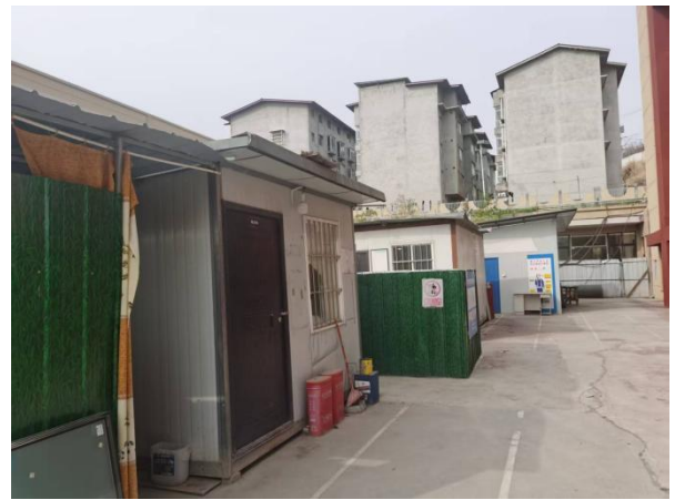
项目已建施工场地
