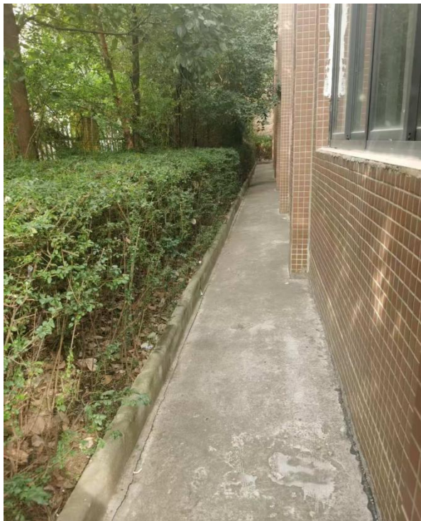
项目建设现状
