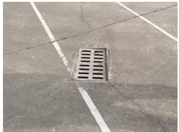
项目已建排水沟及雨水口
