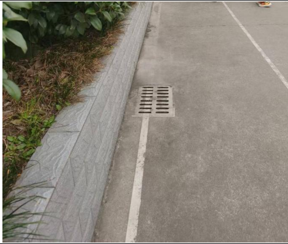
项目已建排水沟及雨水口
