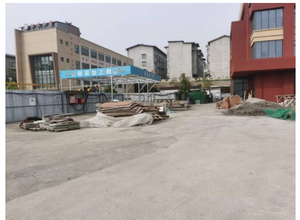
项目建设现状
