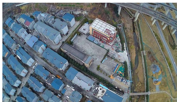
项目建设现状
