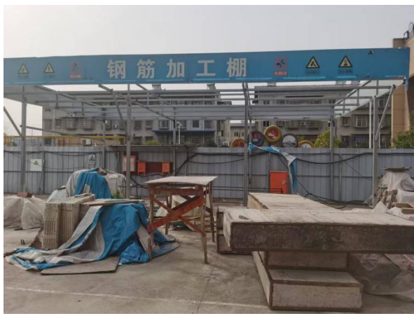
项目已建施工场地
