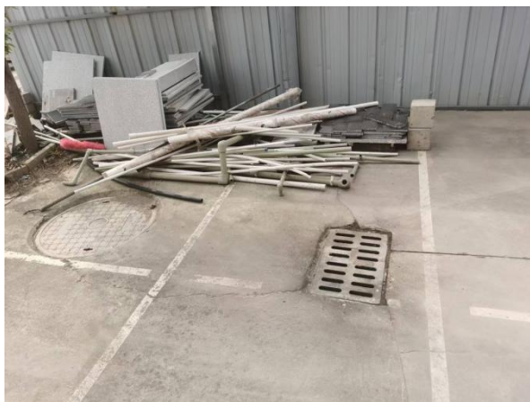
项目已建排水沟及雨水口
