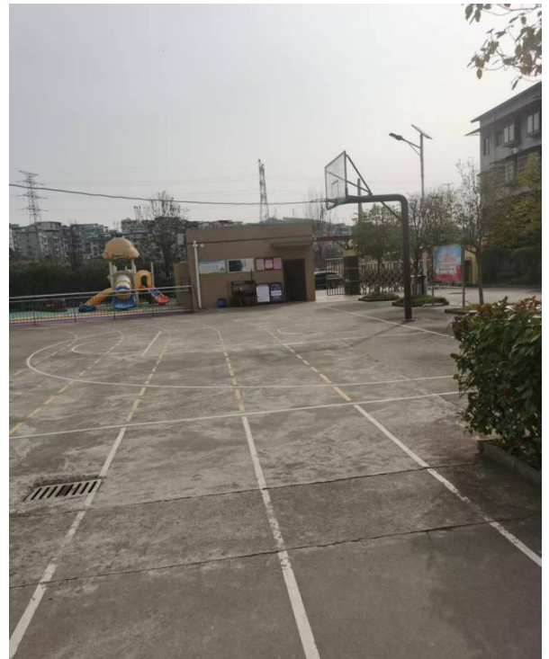
项目建设现状
