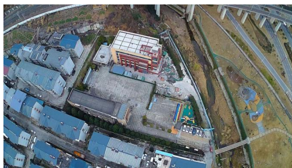
项目建设现状
