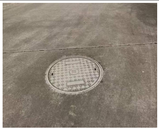
项目已建排水沟及雨水检查井
