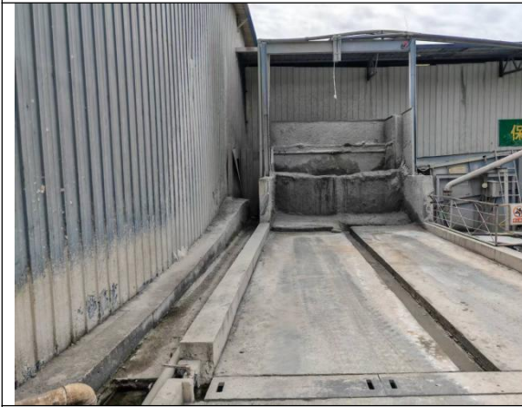
项目已建洗车槽
