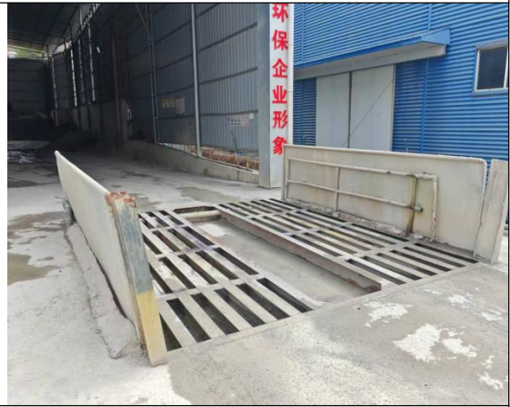
项目已建洗车槽
