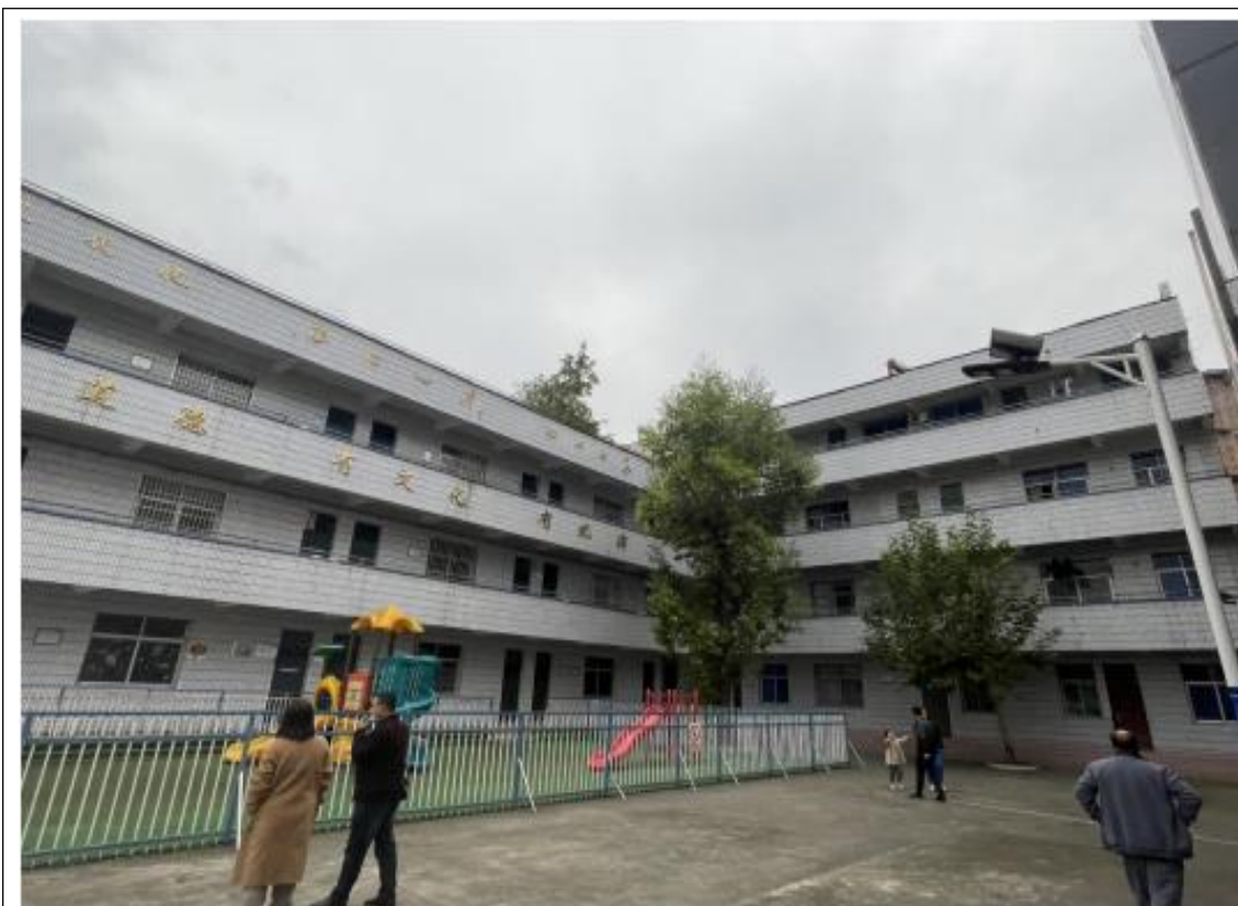
被拆除建筑现状立面
