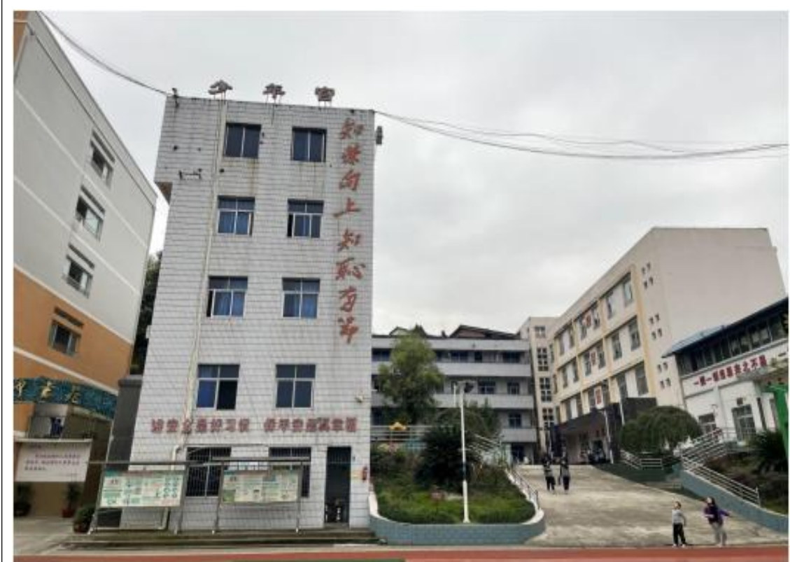
被拆除建筑现状侧立面
