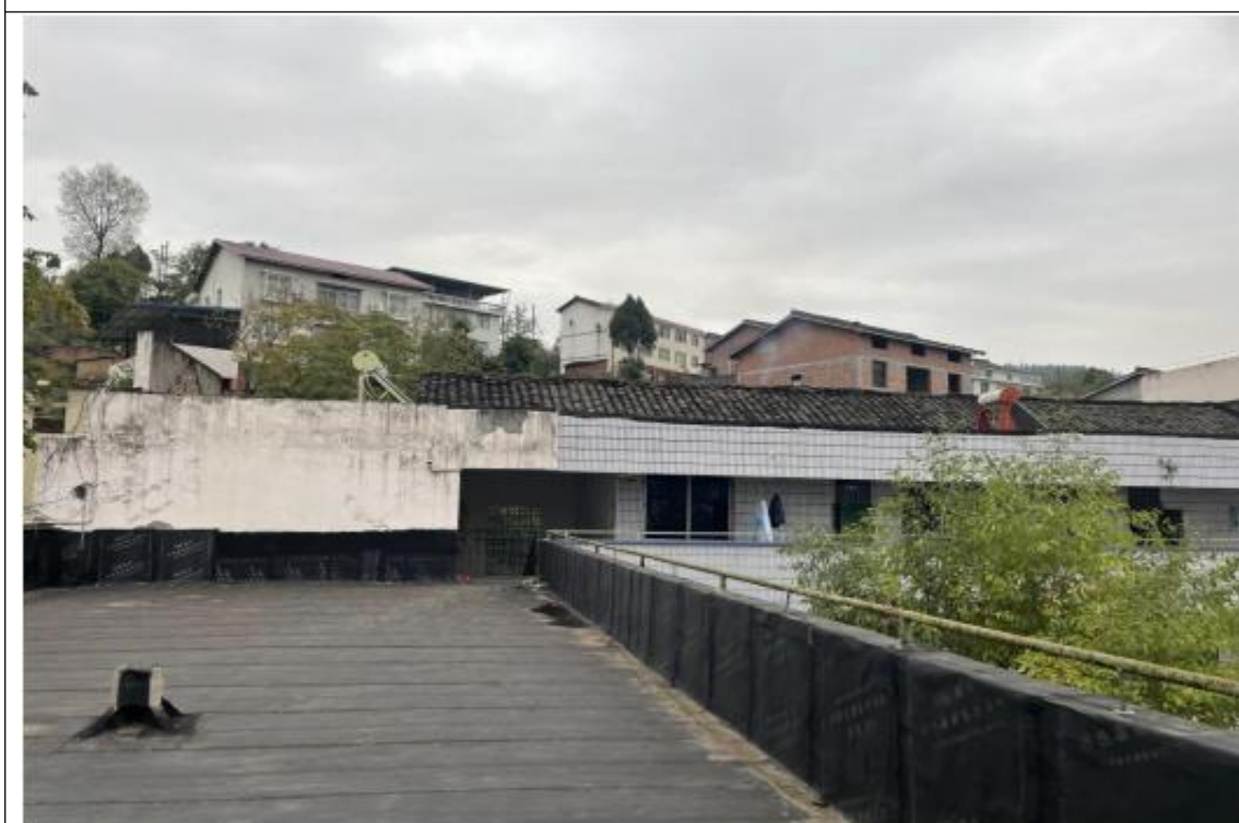
被拆除建筑现状顶层
