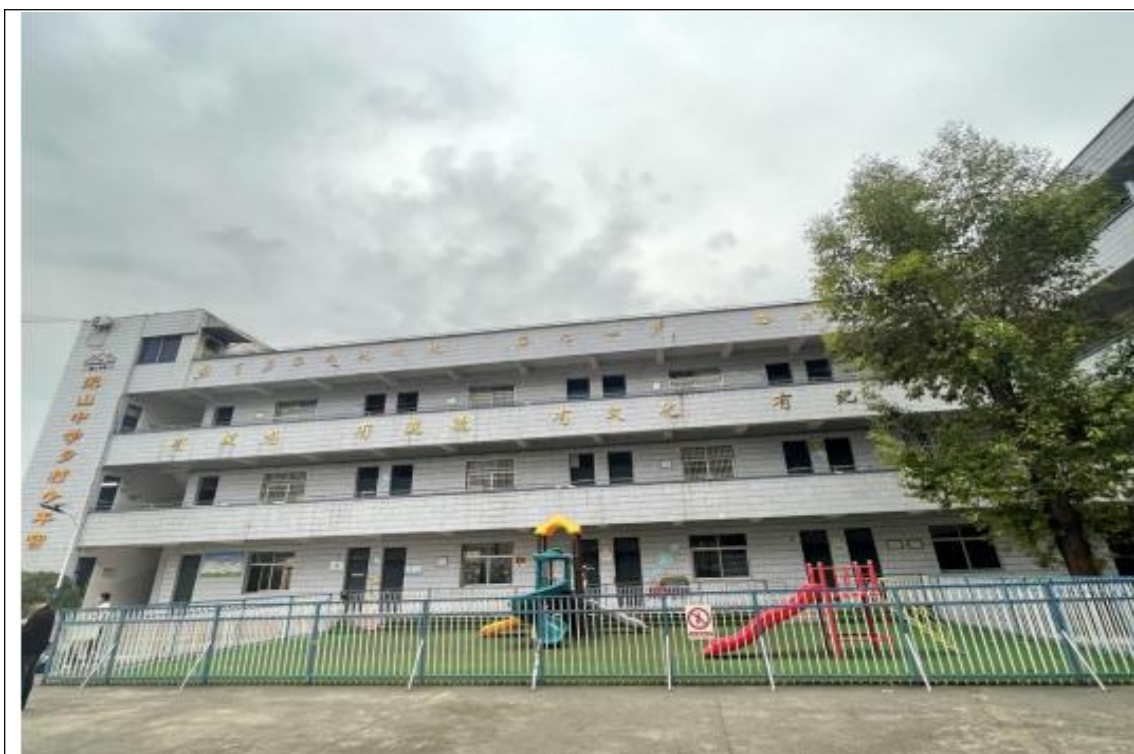
被拆除建筑现状立面
