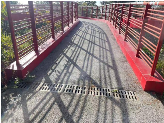
盖板排水沟及桥面
