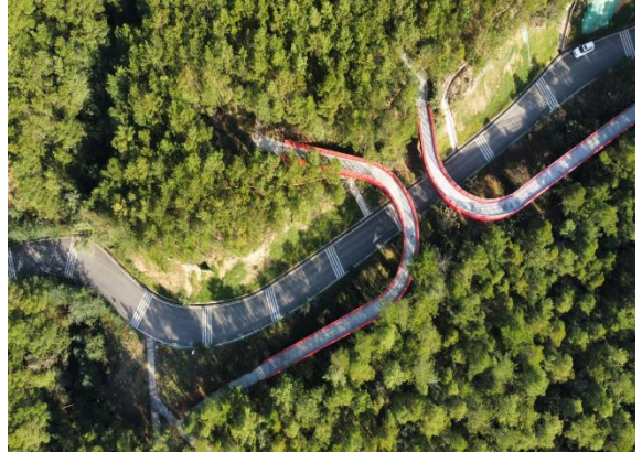
项目区整体现状
