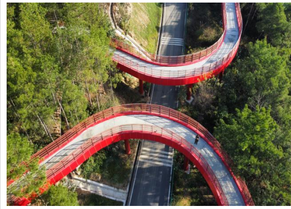
项目区整体现状
