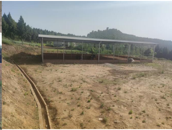
2.6-6 排水沟及场平区
