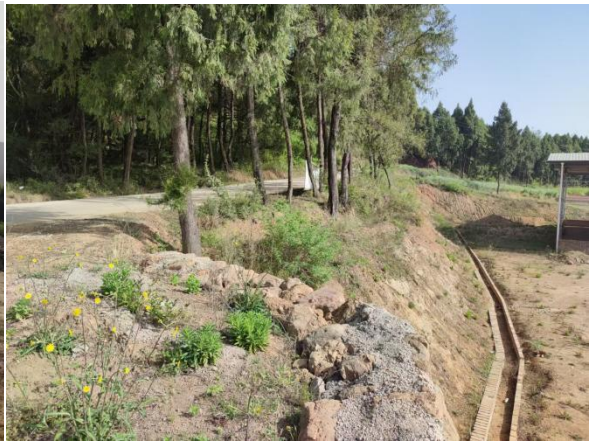
图 2.6-4 浆砌砖排水沟
