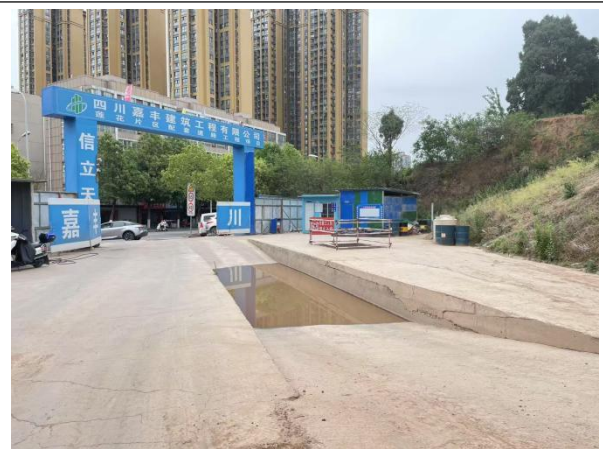
进场入口处洗车槽
