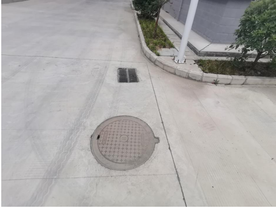
雨水口及雨水检查井
