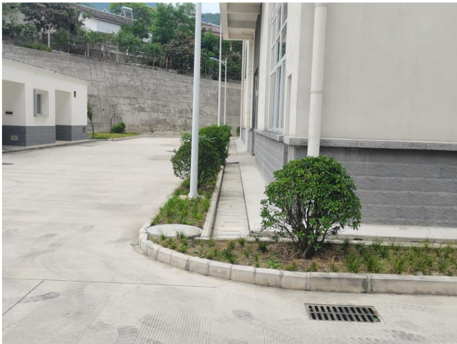
建筑周边盖板排水沟
