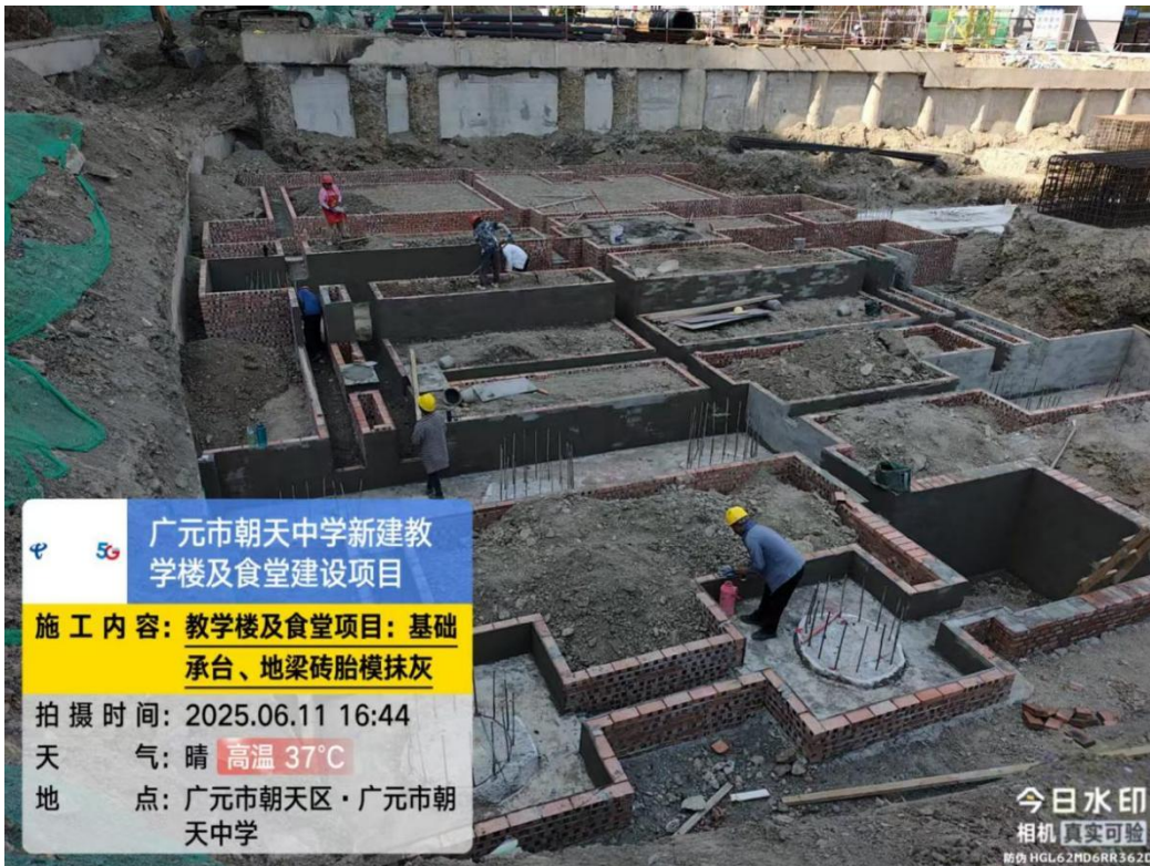
项目建构筑物施工现状
