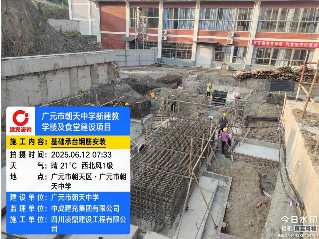
项目建构筑物施工现状
