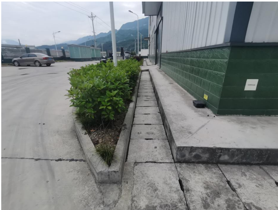
建筑周边盖板排水沟
