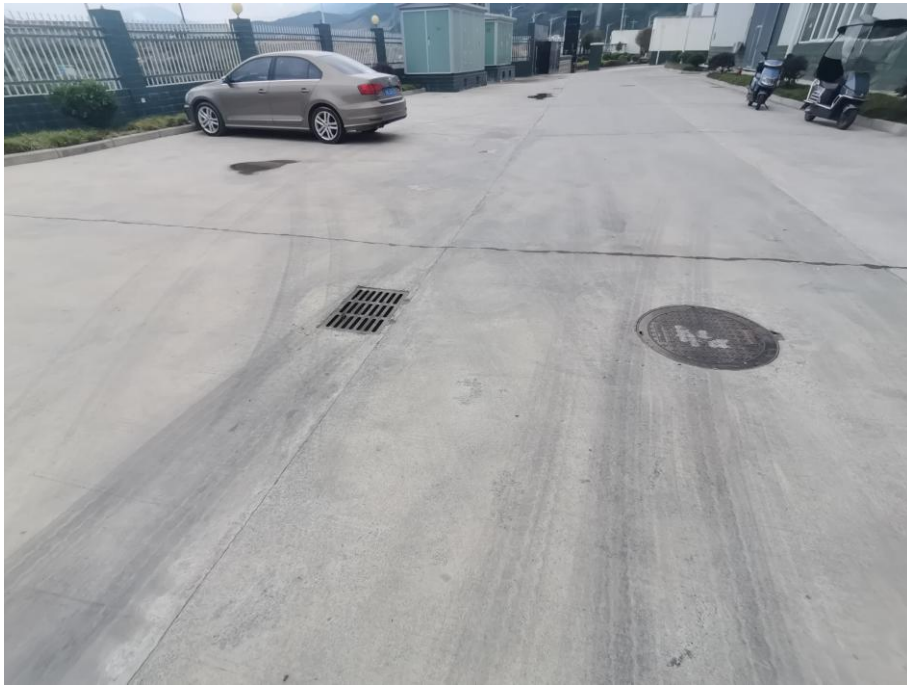
雨水口及雨水检查井
