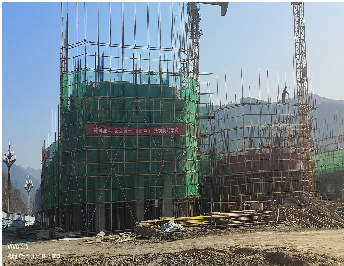
项目区施工现场照片
