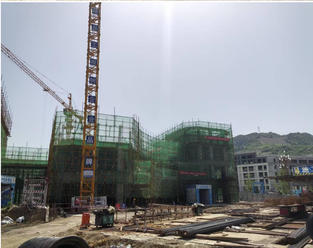
项目区施工现场照片
