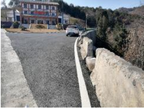
A 线起点 AK0+000 处照片
