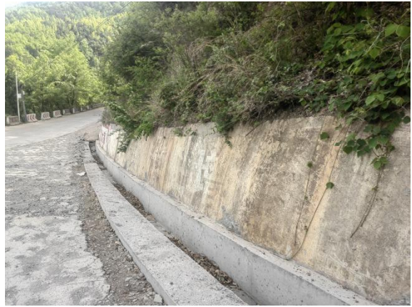
A 线止点 AK3+634.125 处施工过程中照片
