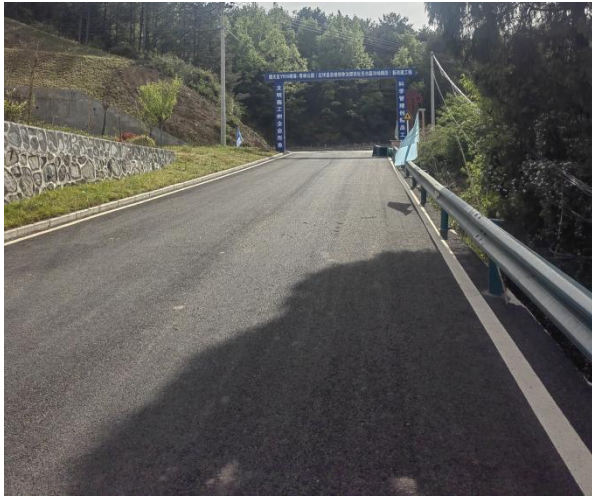
A 线起点 AK0+000 处照片
