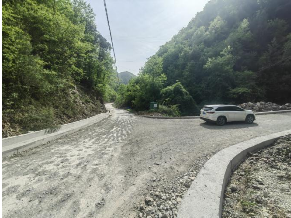
B 线起点 BK0+000 处施工过程中照片 1
