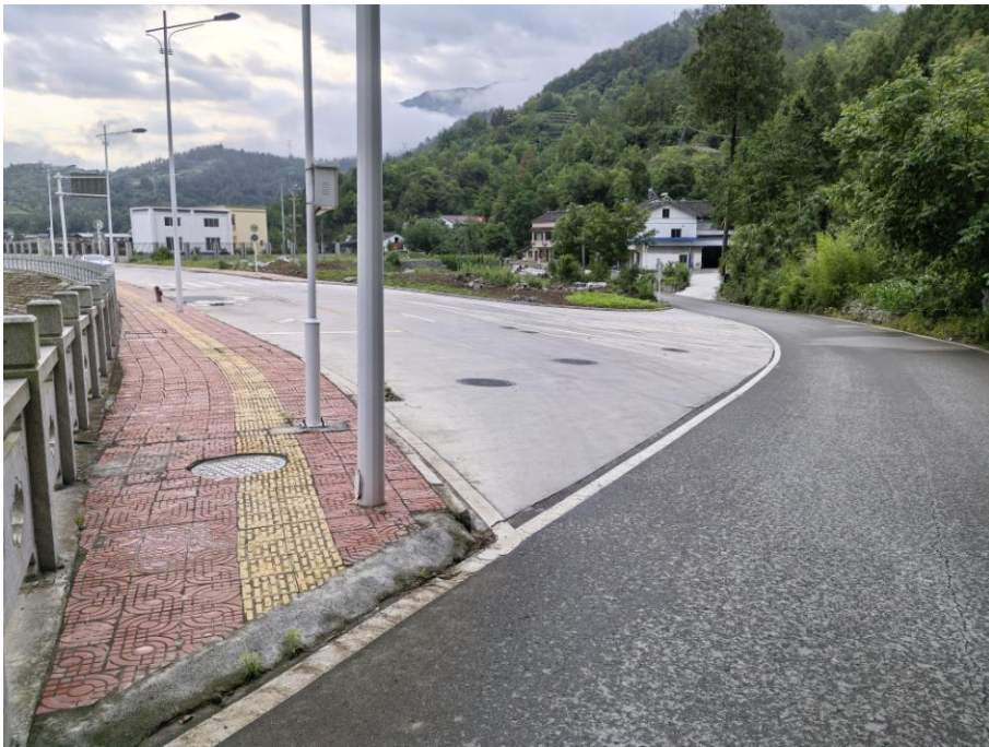
道路起点现状
