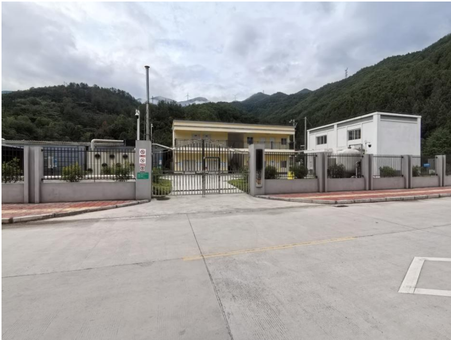
污水处理站现状
