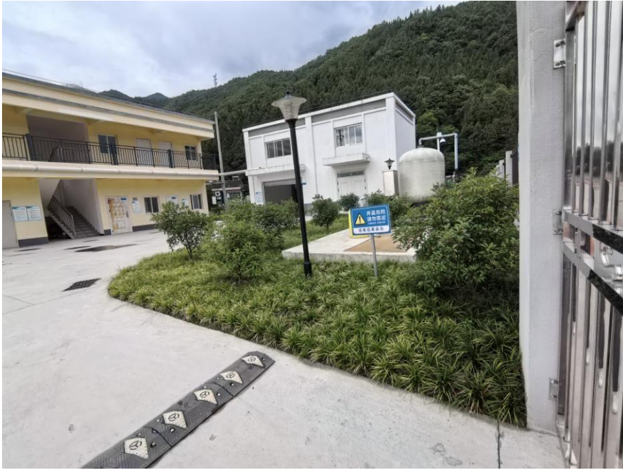
污水处理站绿化区域现状
