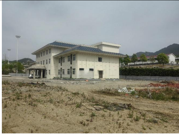
场地右侧建设现状
