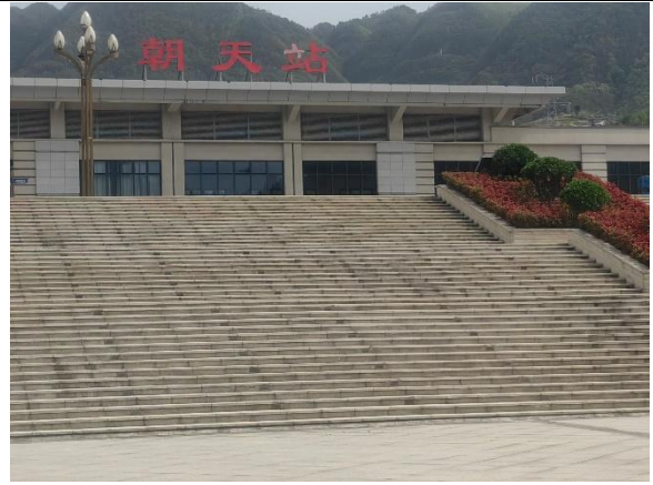
中部西城铁路朝天站台阶
