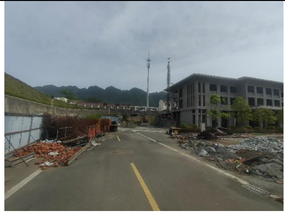
场地左侧建设现状
