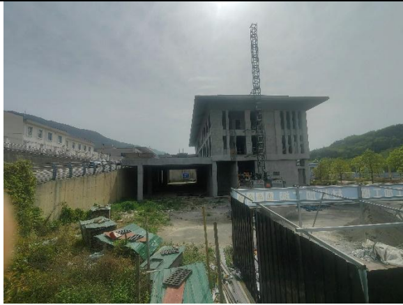
场地左侧建设现状
