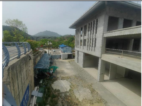
场地左侧建设现状及施工场地
