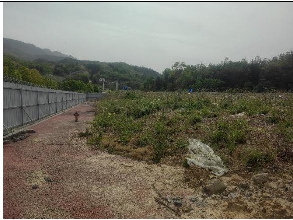
场地右侧建设现状
