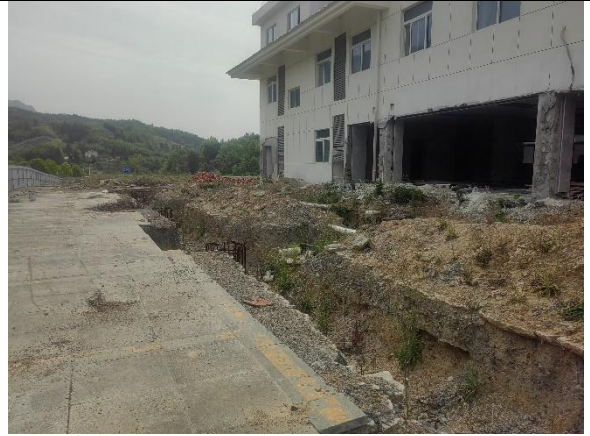
场地右侧建设现状
