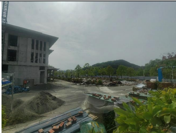
场地左侧建设现状
