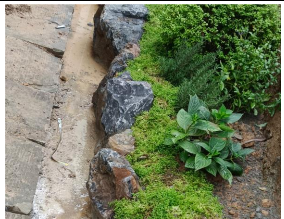
图 6：项目区排水沟现状（二）
