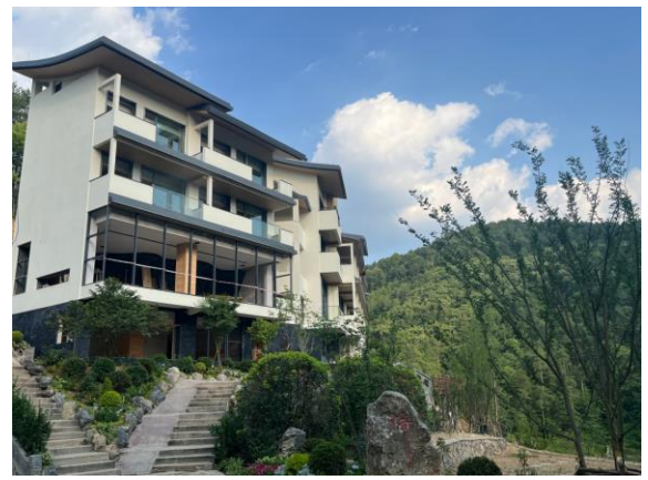
图 2：项目区建构筑物现状（二）
