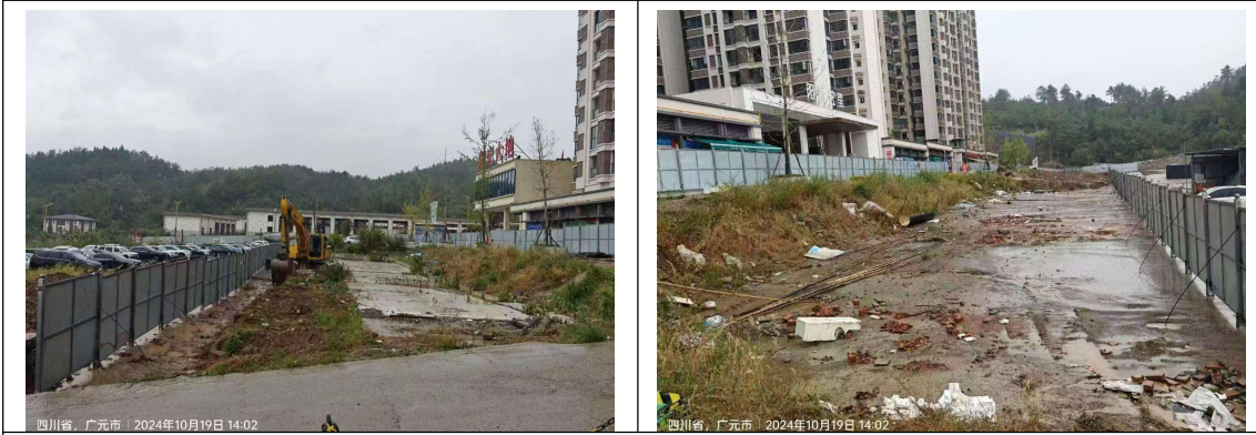
施工前原状情况
