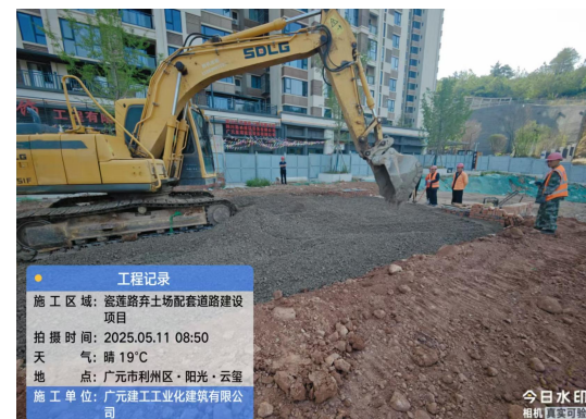
道路路基铺设现场影像
