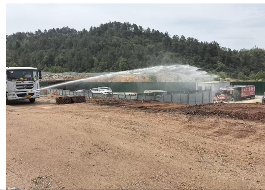
回填后降尘现场影像
