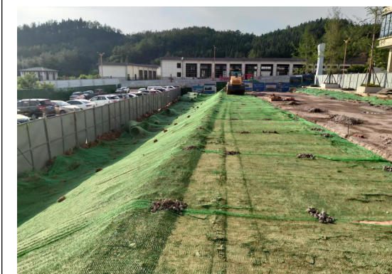
苫盖回填路基现场影像
