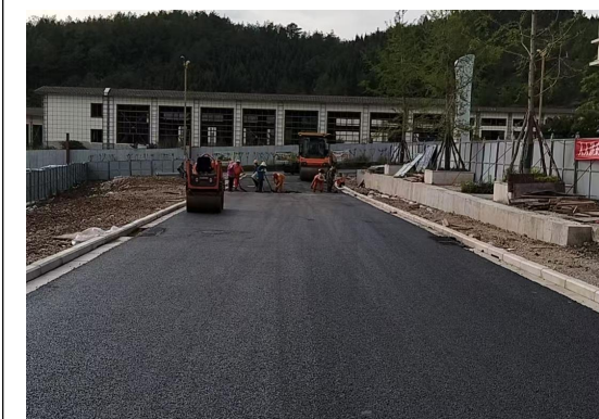
沥青路面铺设现场影像
