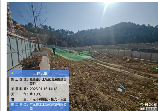
开挖后苫盖表土
