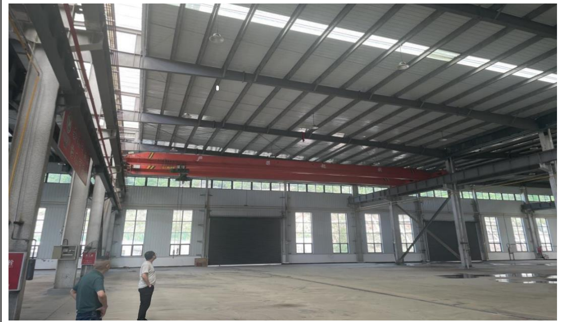
图 3: 已建厂房局部加高改造
