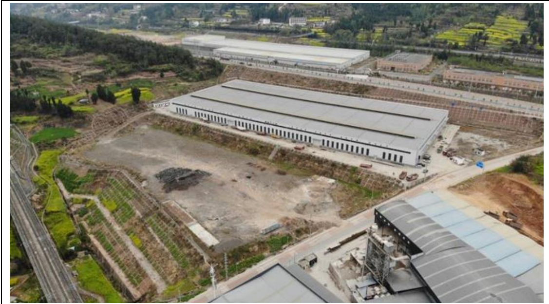
图 1: 新建厂房区域现状
