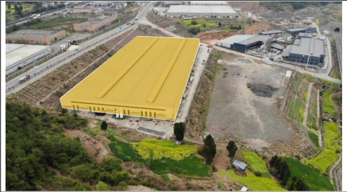
图 3: 已建厂房现状
