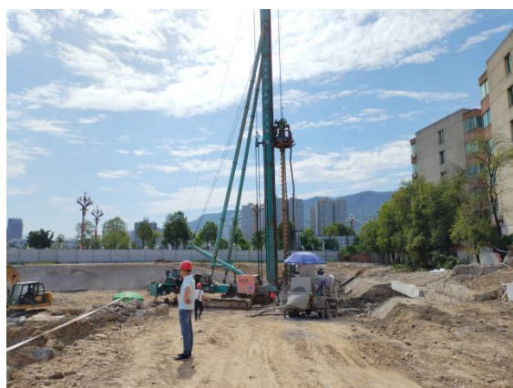
场地东侧基坑现状
