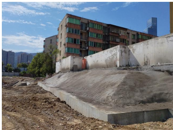
场地南侧基坑现状
