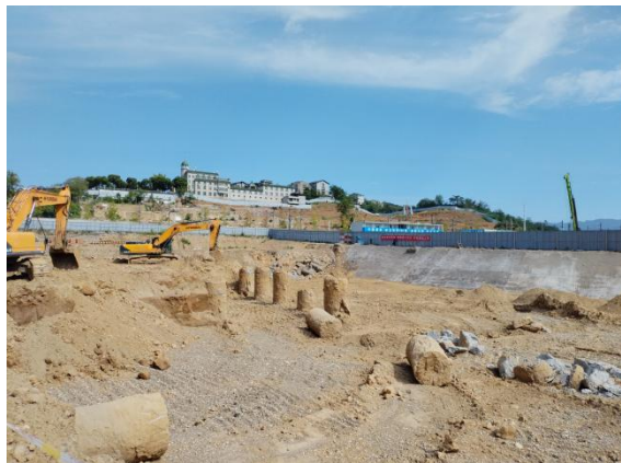
场地北侧基坑现状
