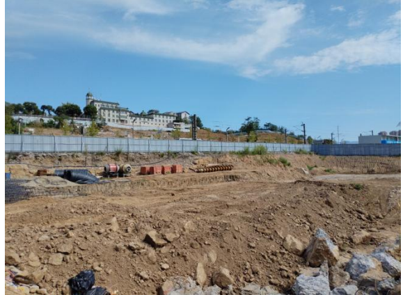
场地西北侧现状
