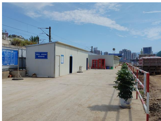
场地 1#楼北侧施工项目部及工人宿舍
