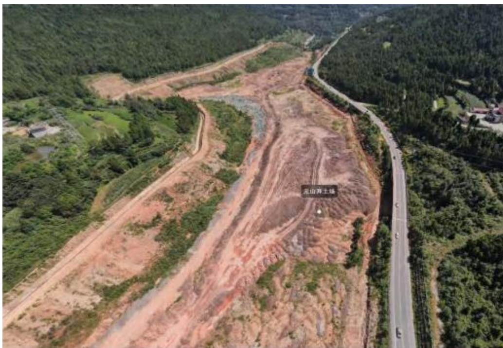
图 3.2-1 元山弃土场航拍图
