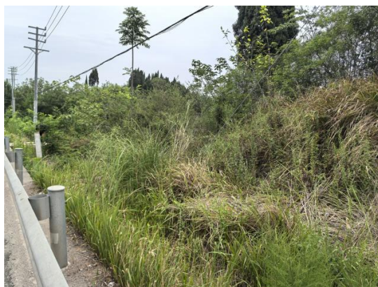
先锋给水管道工程区撒播植草
