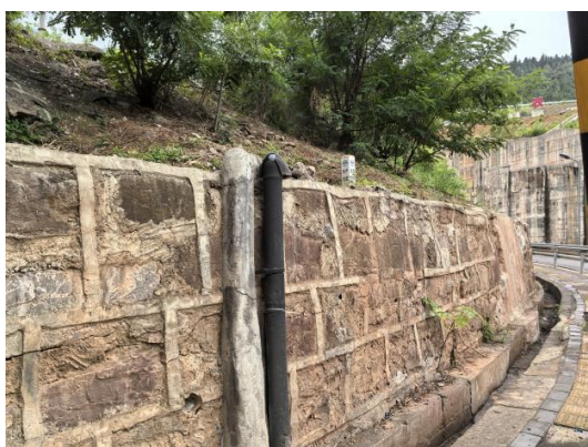
万缘道路给水管道工程区排水沟
