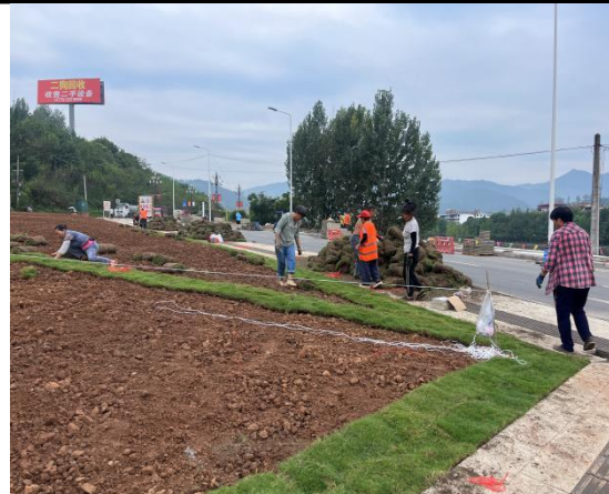
图 2.4-2 回铺表土区域现场照片
