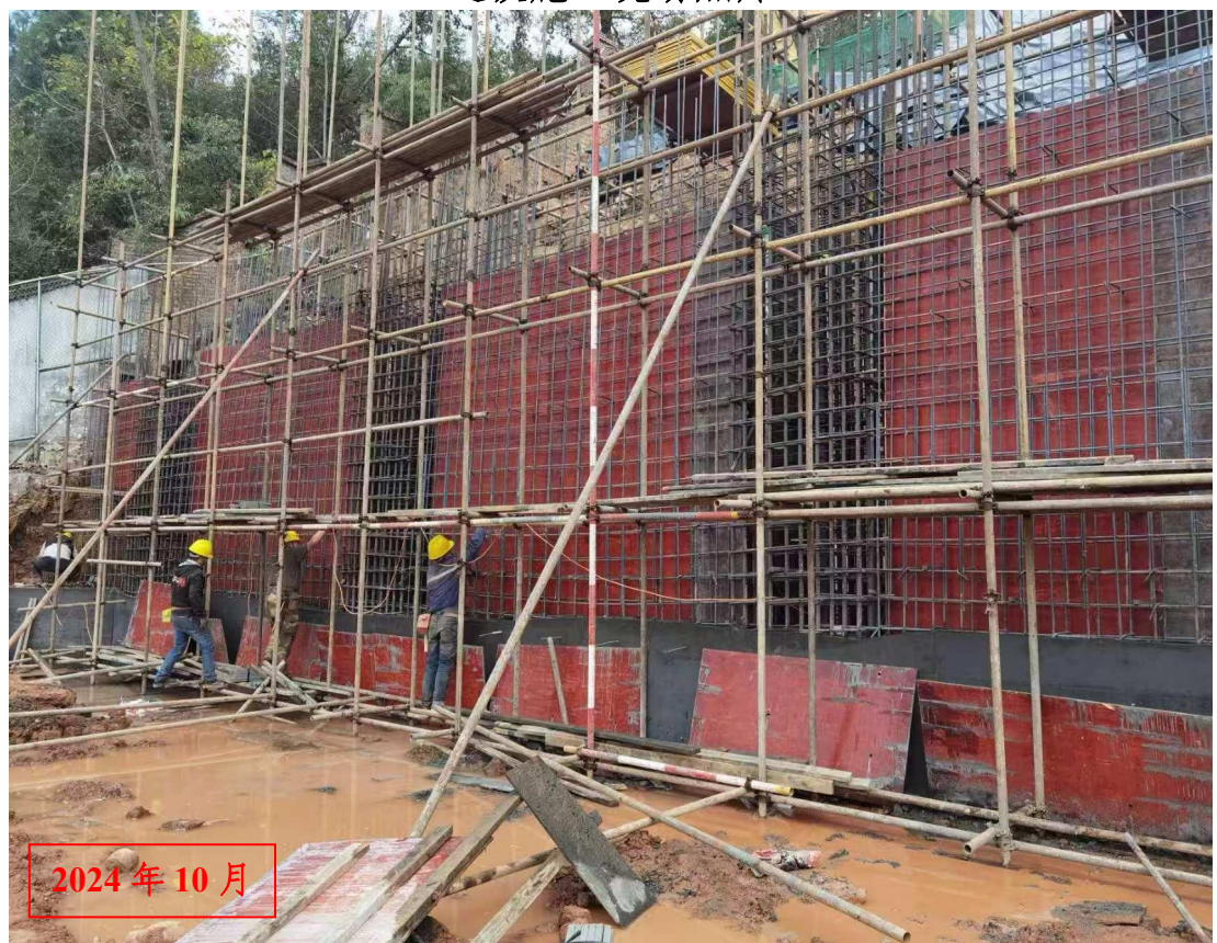
边坡施工现场照片
