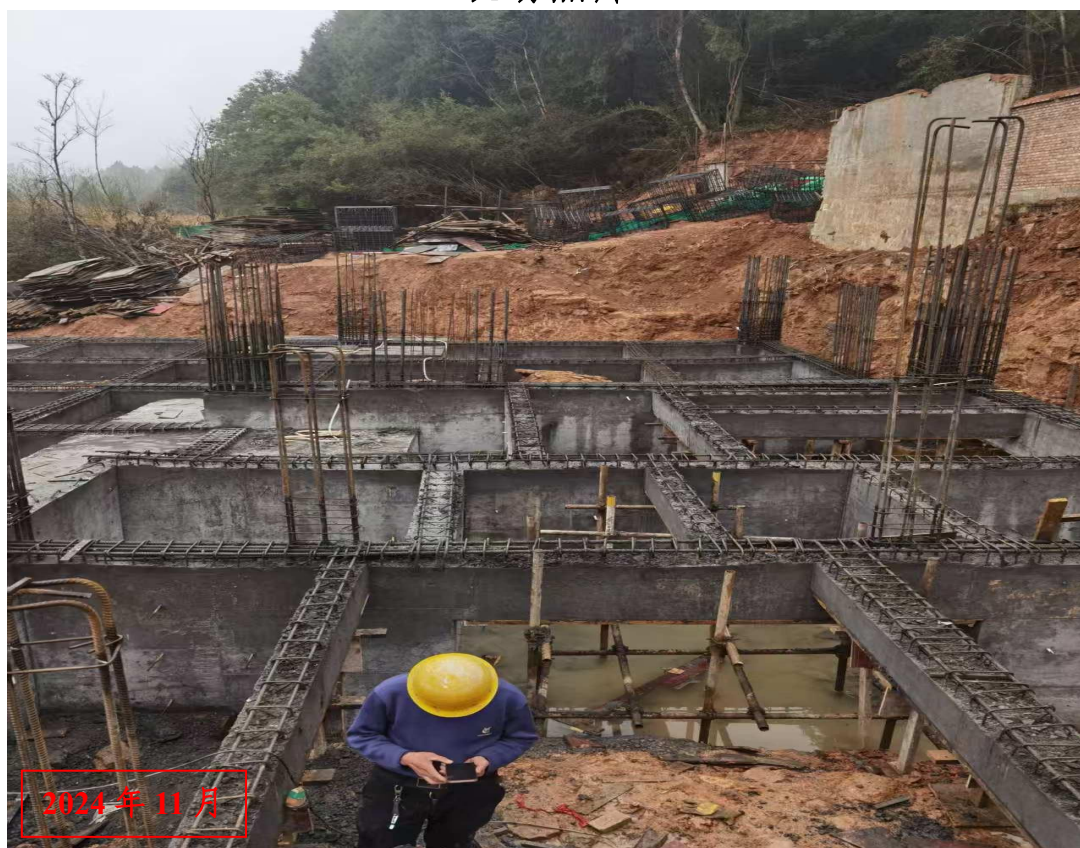
建筑物基础施工现场照片
