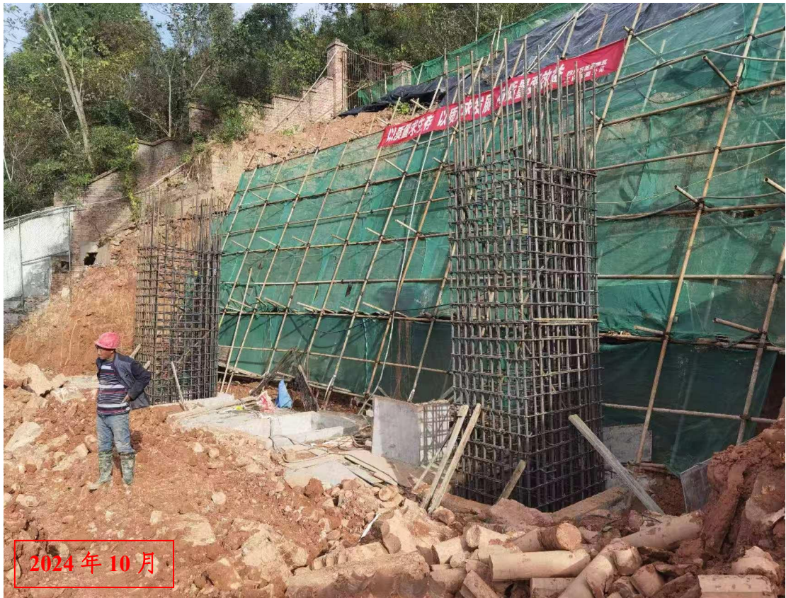
边坡施工现场照片
