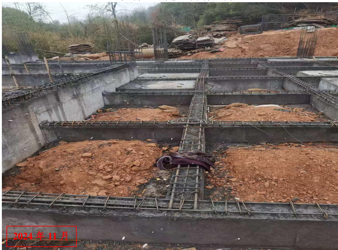
建筑物基础施工现场照片
