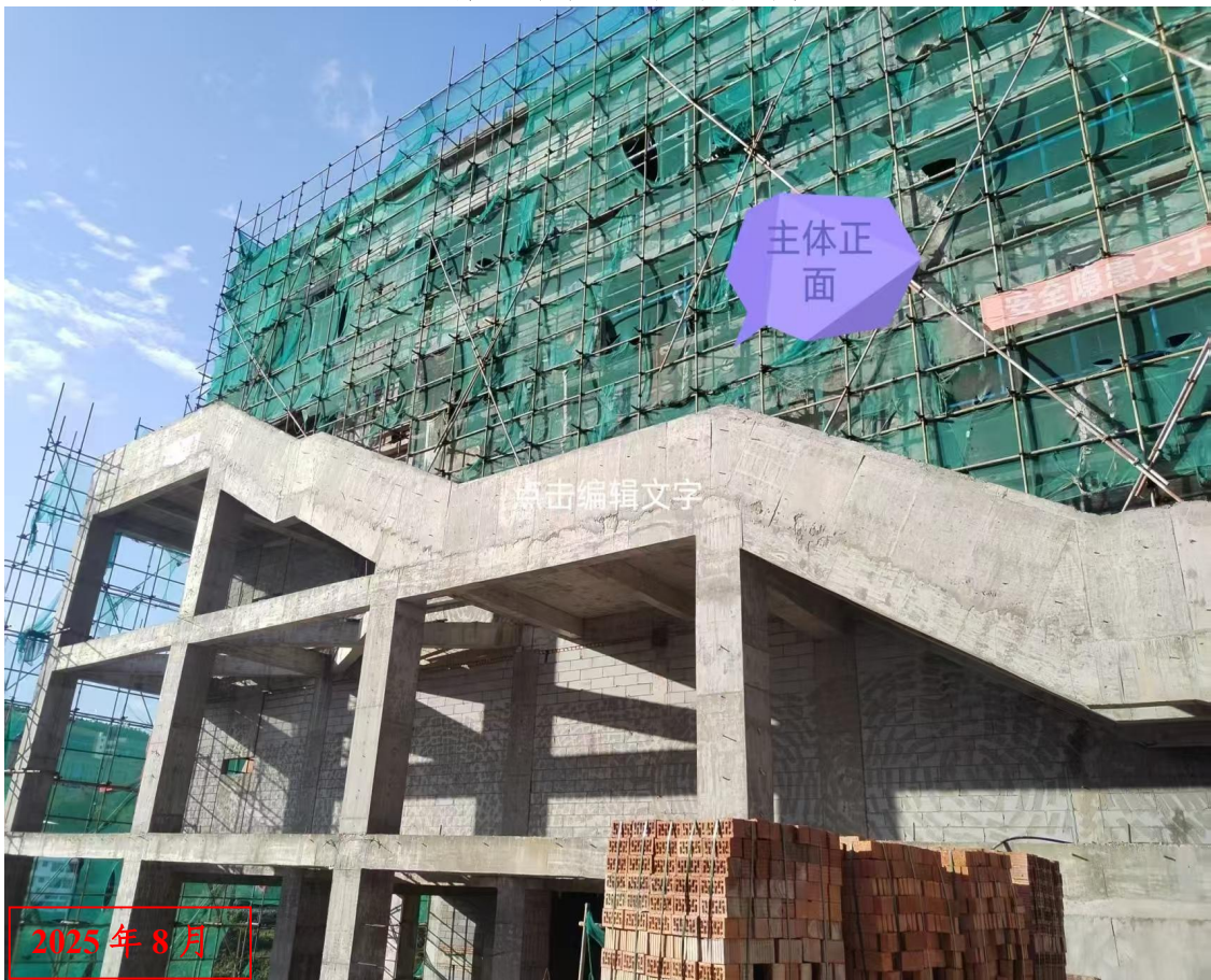
主体工程施工现状照片
