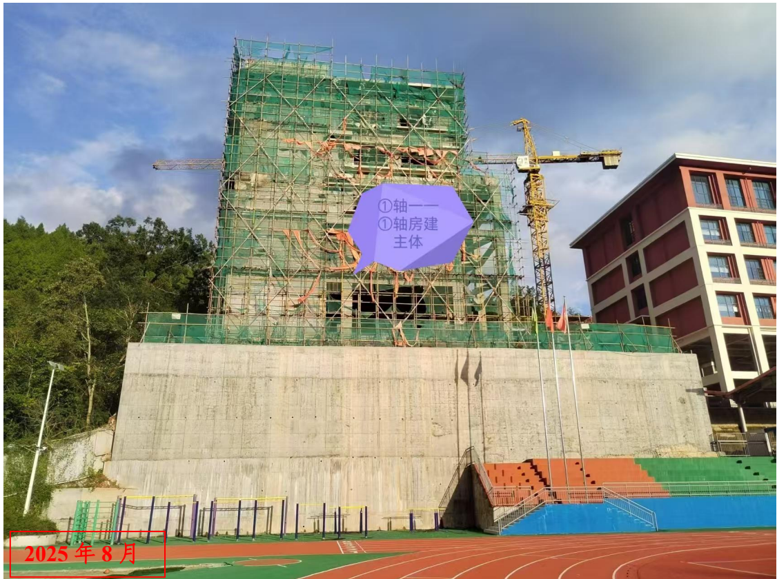
主体工程施工现状照片
