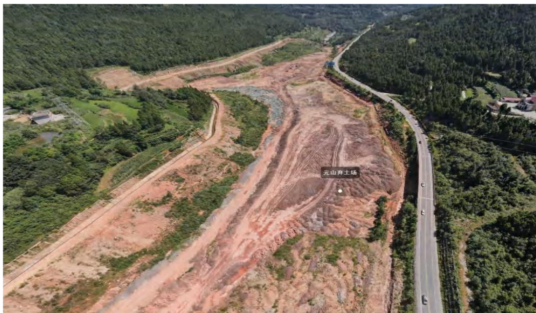
利州区龙潭乡元山弃土场照片
