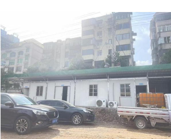
地块南侧施工项目部
