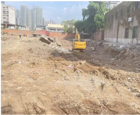
基础开挖现状
