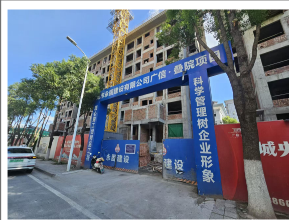
北侧施工出入口
