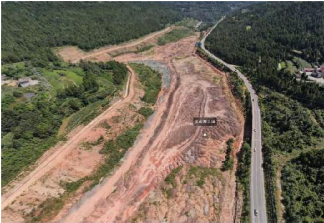
图 3.2-1 元山弃土场航拍图
