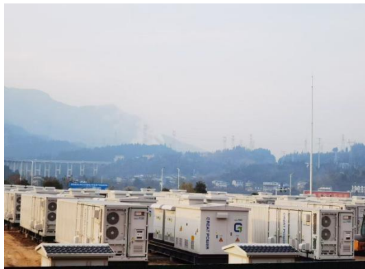
主体工程现状 (2025.12)
