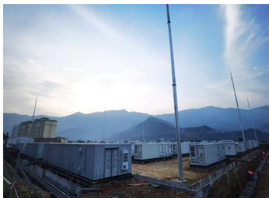
主体工程现状 (2025.12)
