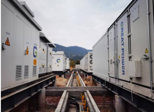
场地内电缆沟现状 (2025.12)
