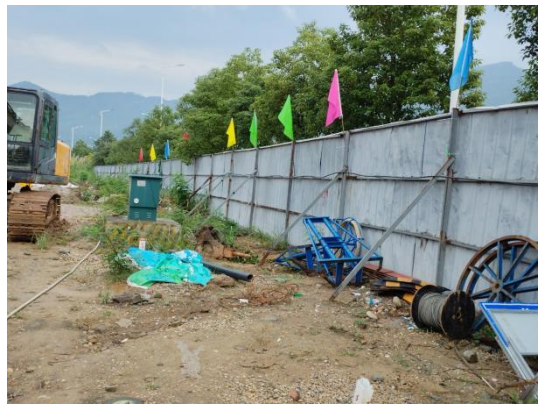
临时围挡现状 (2025.10)
