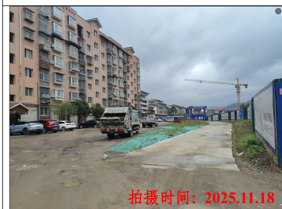
项目临时表土堆场
