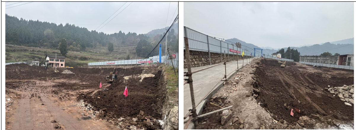
主体工程区内部现状（临时堆土）
