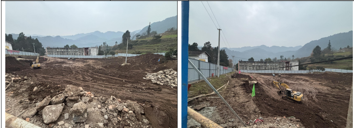
主体工程区内部现状
