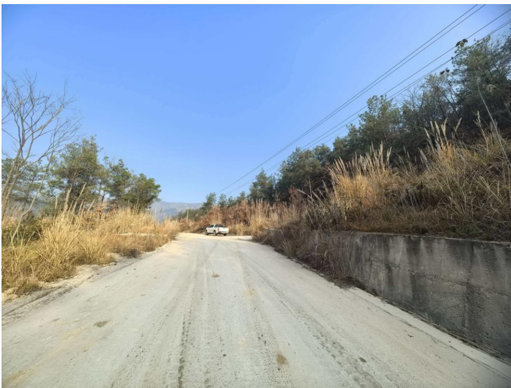
项目场地下部道路现状
