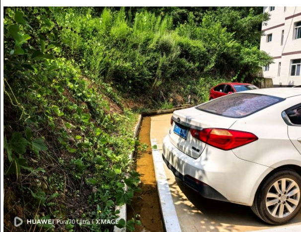
边坡绿化及排水沟
