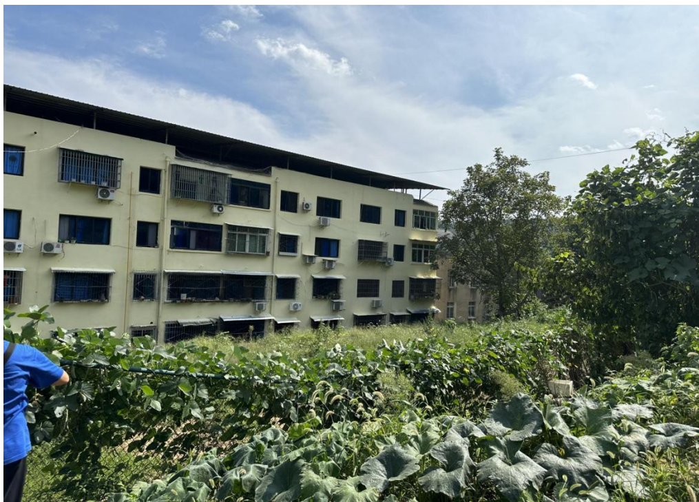
图 2.4-1 进场前原地貌现场照片
