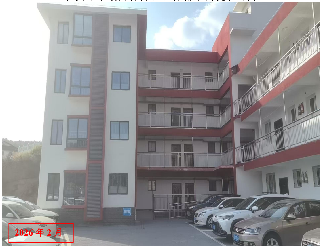
剑门中学教师保障性住房建筑物现状照片
