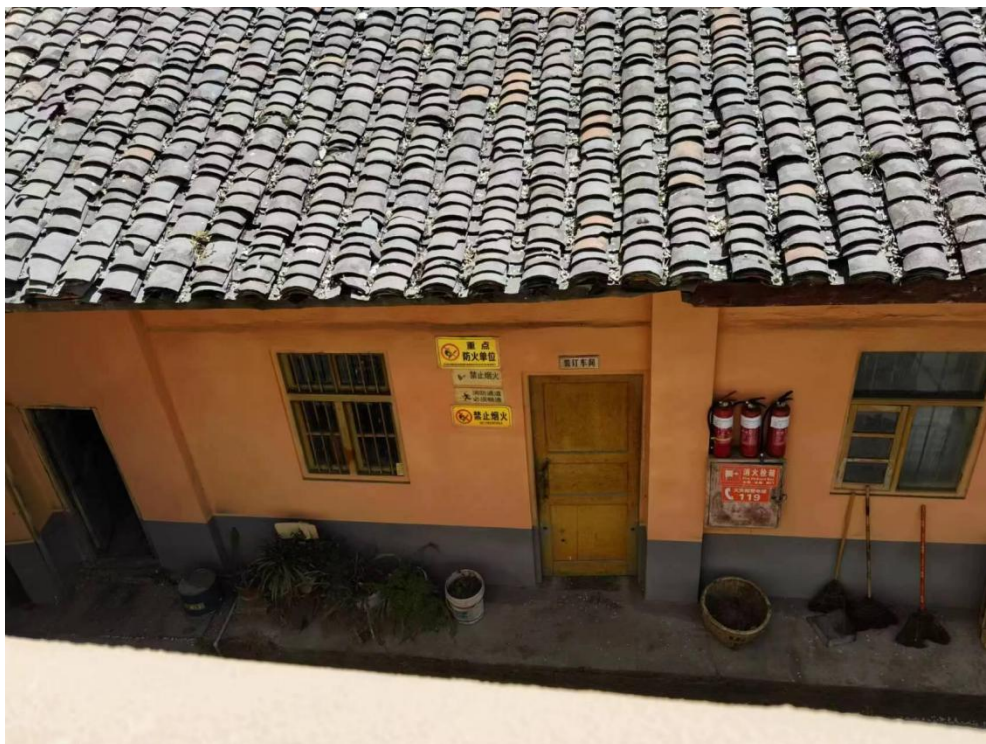
图 2.4-1 进场前原地貌现场照片
