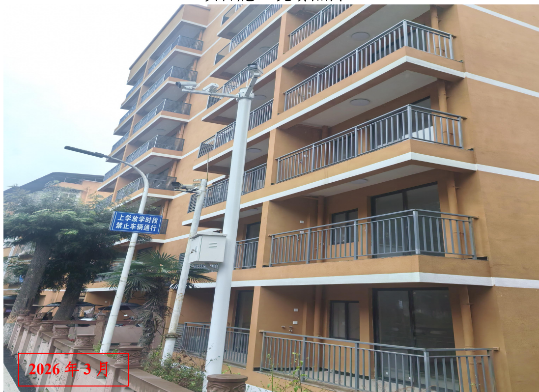
项目建筑物现状照片
