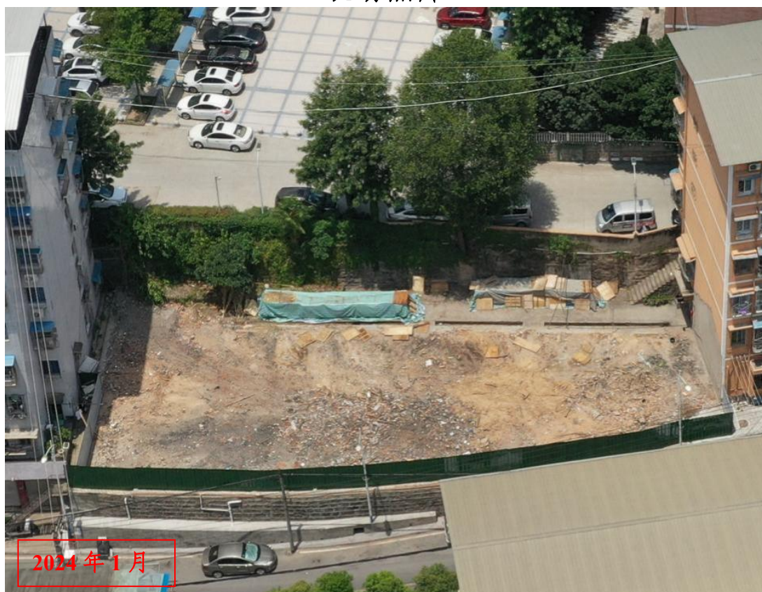
项目施工现场照片
