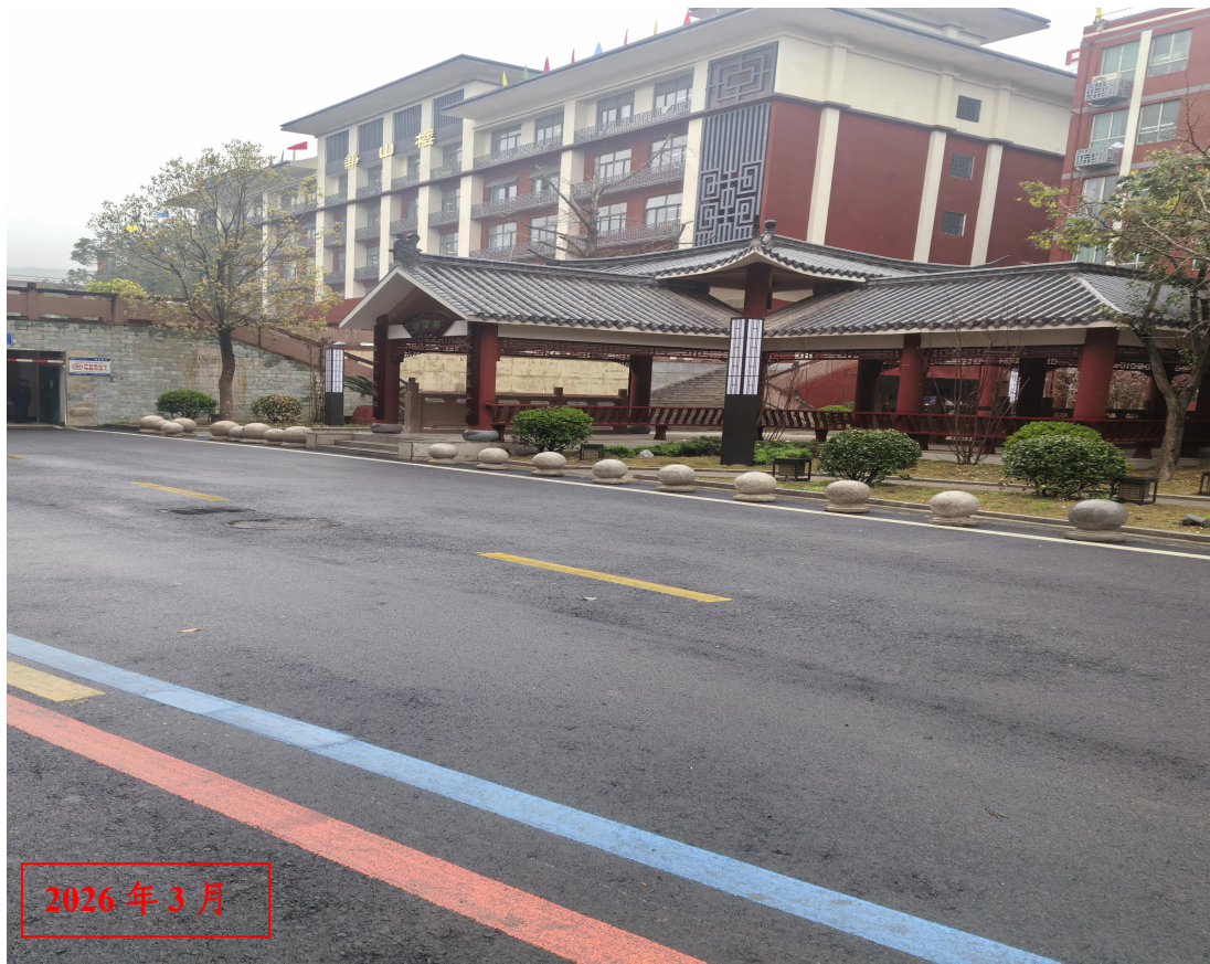
道路工程现场照片
