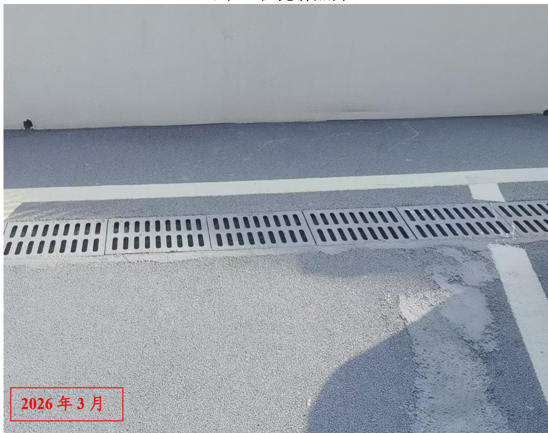
散水沟现状照片
