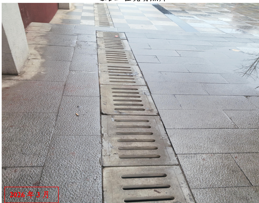
散水沟现状照片
