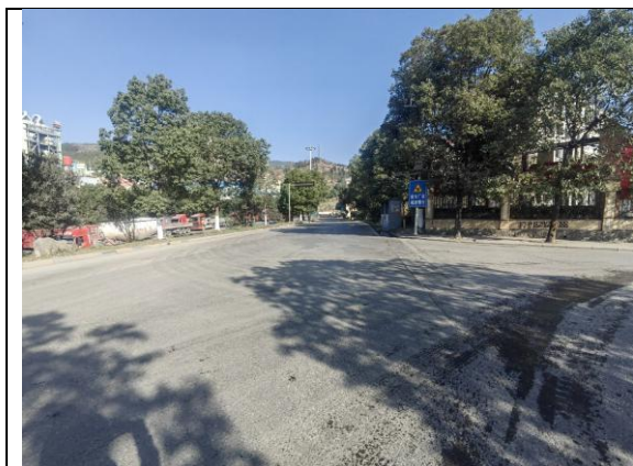
桥梁起点处现状
