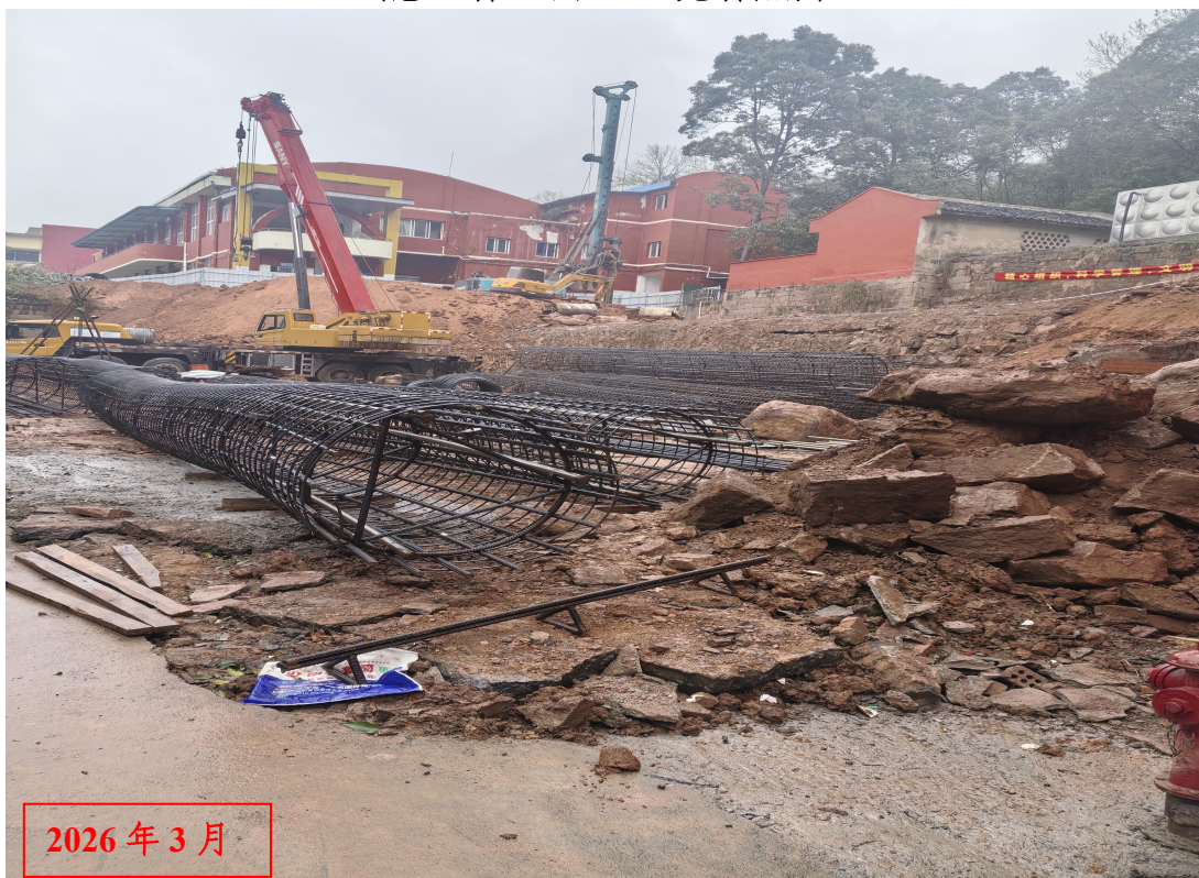
建筑物基础施工现场照片
