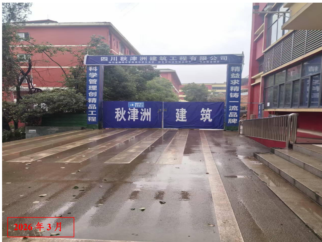
施工场地出入口现场照片
