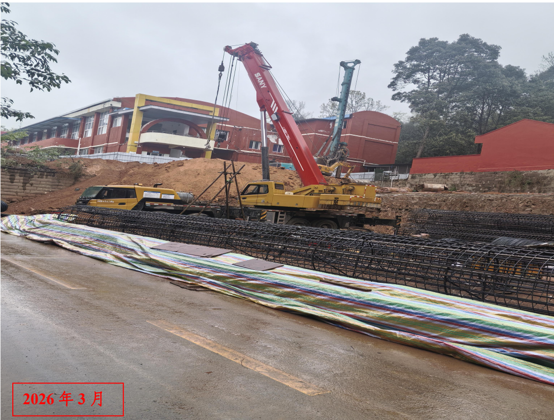
施工临时苫盖现状照片
