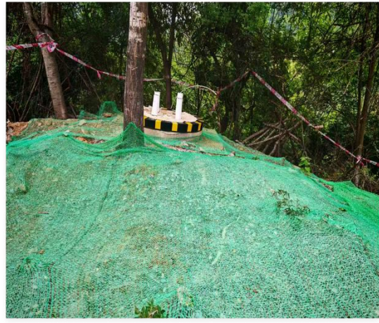
塔基工程临时苫盖工程
