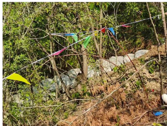
塔基工程土袋挡护措施
