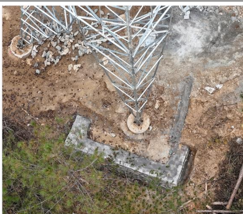
塔基工程旁侧排水沟
