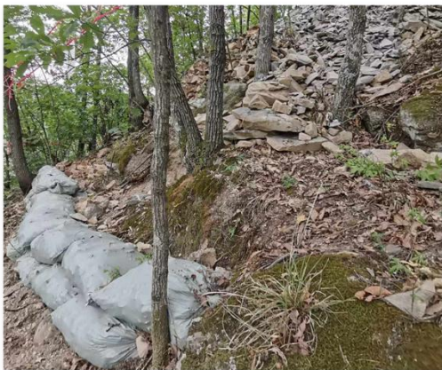
塔基工程土袋临时挡护措施
