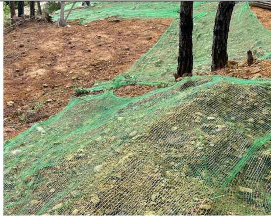
塔基工程临时堆土及苫盖措施
