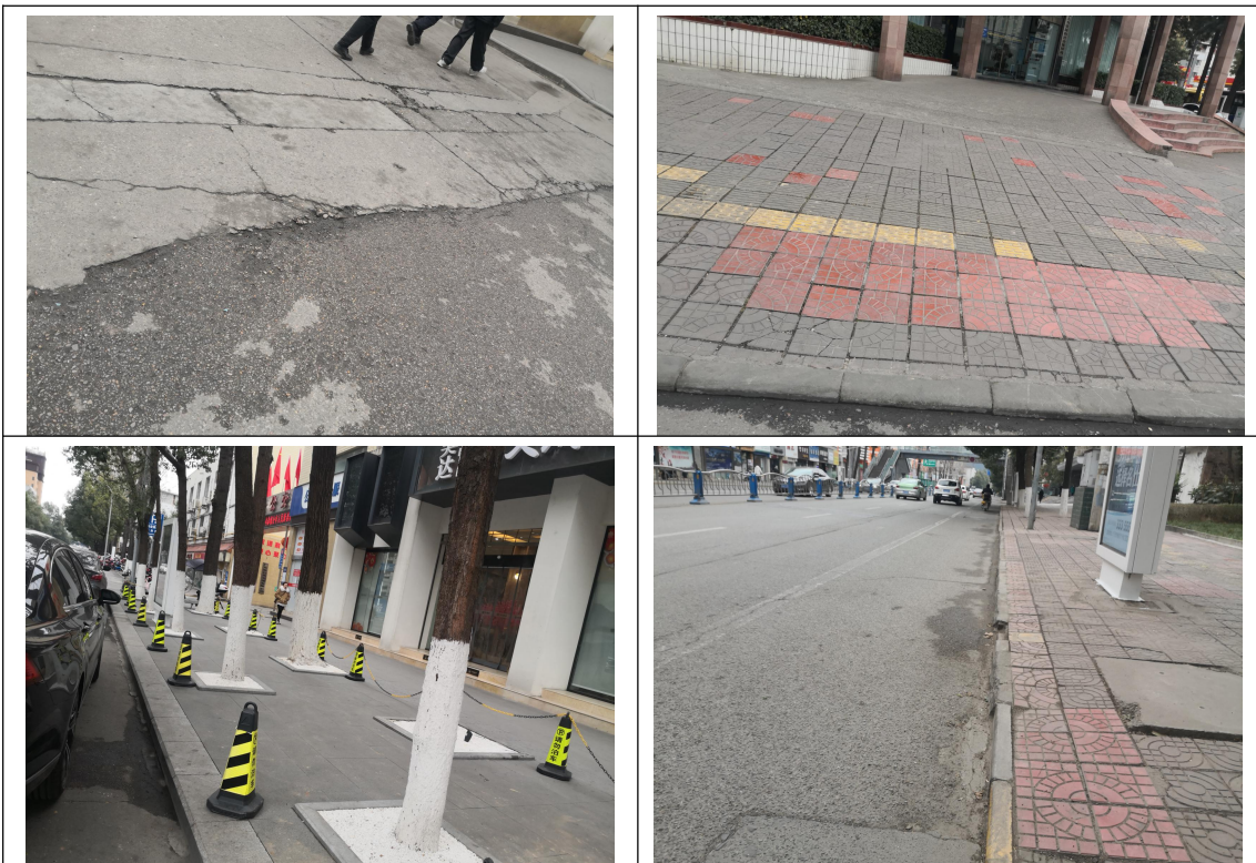
电子路人行道改造前
